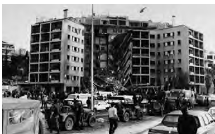
Eksempler på progressiv kollaps av bygninger, henholdsvis Murrah Federal Building i Oklahoma City i USA og USAs ambassade i Beirut i Libanon etter kjøretøy med eksplosiver på utsiden av byggene. FOTO AP / NTB Scanpix (the American Embassy in Beirut, Lebanon, after a huge bomb blast) og Charles Porter IV / Zuma Press / NTB scanpix (Oklahoma City Bombing)
