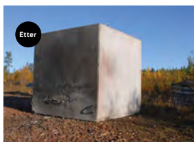
Utvendig eksplosjon med en ren 7 kg eksplosivladning på 1 meter avstand mot en betongkonstruksjon.
