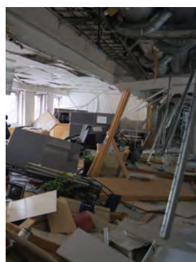
Regjeringskvartalet i Oslo 22. juli 2011 og skader på bygninger på grunn av trykkbølgen i luft. FOTO Forsvarsbygg
