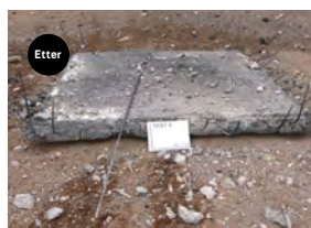
Innvendig eksplosjon i en betongkonstruksjon fra en ren 7 kg eksplosivladning.
