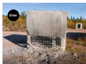
Utvendig eksplosjon med en fragmenterende granat med 7 kg eksplosiver på 1 meter avstand. FOTO Forsvarsbygg
