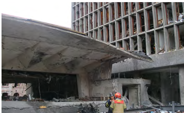
Regjeringskvartalet i Oslo 22. juli 2011 og skader på bygninger på grunn av trykkbølgen i luft. FOTO Forsvarsbygg
