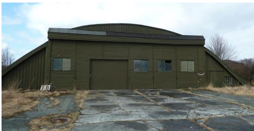
Figur 4-35. A25. Hangar 1, Messerschmidthangar fra 1945 med betongdekke.
