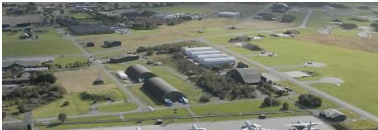
Figur 5-13.: Ørland hovedflystasjon (kilde: NRK)
