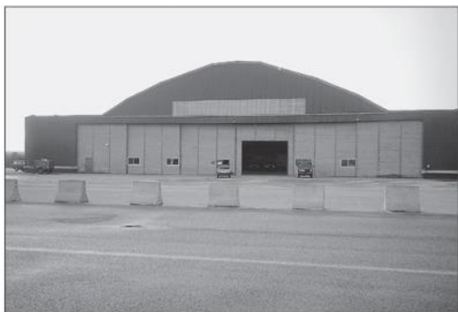
Figur 4-64. Hangar A (Kilde: Forsvarsbygg)
