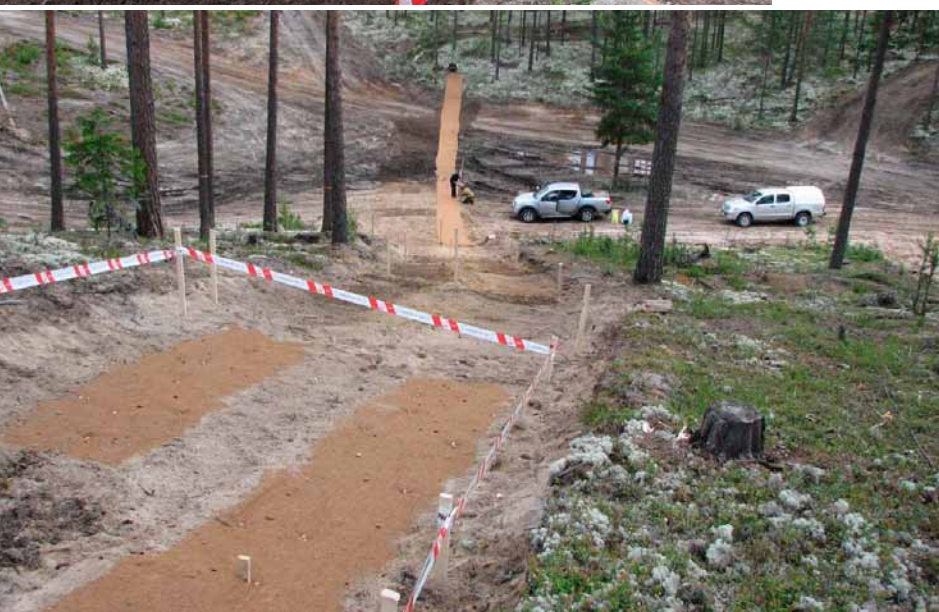
Figur 9.10. Organiske matter av kokosfibre er lette å legge på, og de stabiliserer overflata. Også på svært skrin jord. Matta må festes godt til bakken dersom den skal fungere optimalt. Metoden er relativt kostbar, men kan være aktuell på mindre områder med spesielle utfordringer. Foto: D. Hagen.
