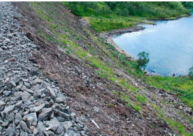
Figur 7.2. Ustabile masser fører lett til erosjonsfurer i vegskråninger. Steinfylling langs E10 Lofast er dekket med humusholdig jord lagt lett oppå fyllinga, og dette har vist seg å gi stabile masser. Foto: A. B. Skrindo.
