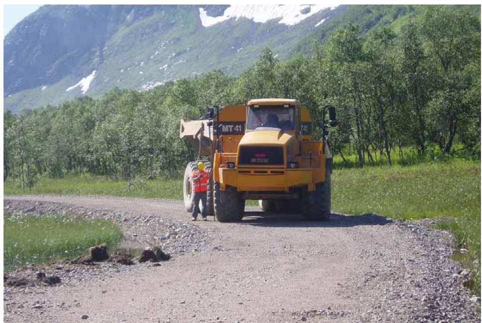
Figur 8.3. I forbindelse med vegprosjektet Lofast var det behov for midlertidige anleggsveger. Vegen på bildet ble fjernet etter bruk. Foto: E. Kongsbakk.
