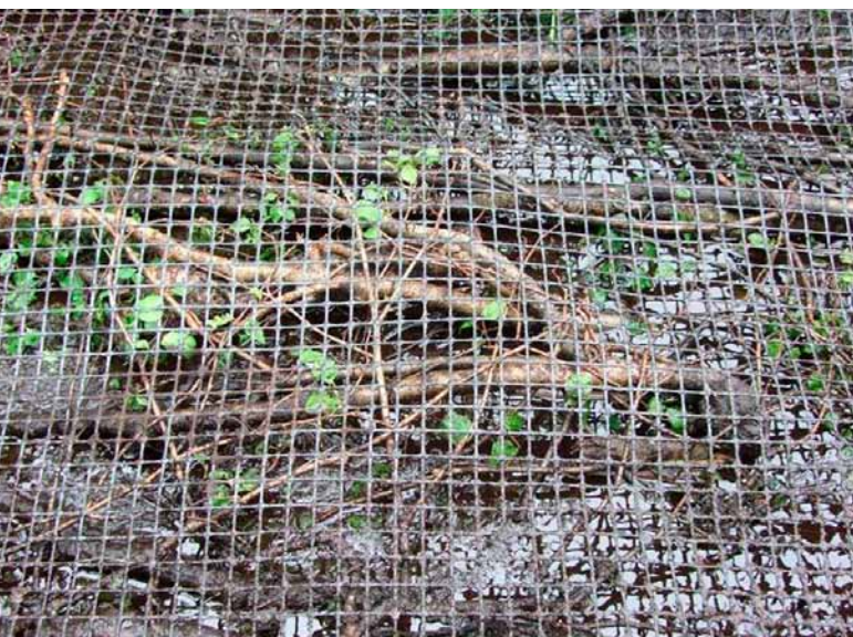
Figur 9.9. Røtter/greiner/kvist er brukt for å stabilisere grunnforholdene i blaut myr og for å stoppe vannstrøm og erosjonsfare i hellende terreng. Foto: Forsvaret.
