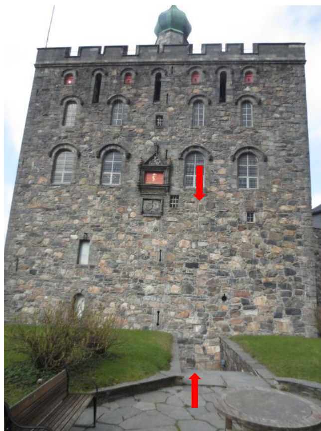
Østre parti til opp under 3. etasje er fra Jørgen Hanssøns forverk ca. 1520. Skillet ses tydelig i muren. Spiret over trappetårnet brakk og falt ned under en orkan våren 2015.
