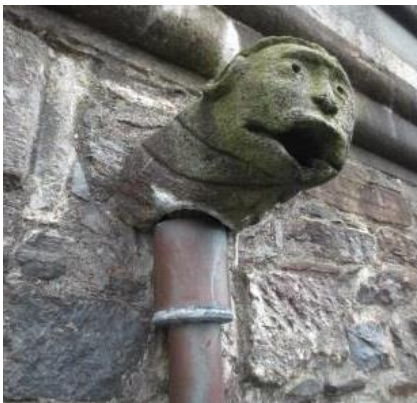
Opprinnelig hugget utspyer av kleberstein på nordveggen, trolig fra 1563. Vannet ble spylt ut gjennom munnen.
