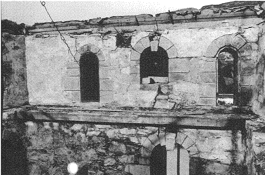
Eksempel på nedraste sluttsteiner i rundbuer over vinduer. Kilde: Fischer-arkivet, Riksantikvaren
