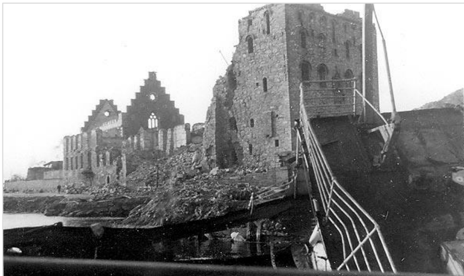
Vestfasaden var særlig hardt skadet. Kilde: Fotomuseum Bergen (internett)
