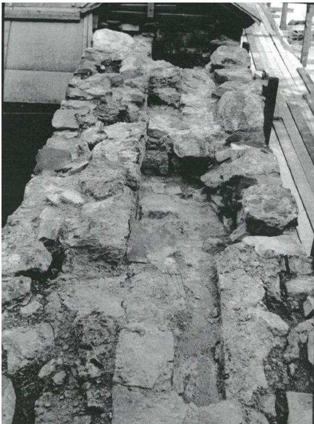
Snitt gjennom kistemuren, som her har en litt underlig todeling/indre vange. Det er uklart hvor bildet er tatt, men det er trolig på toppen av muren under den nedraste kreneleringsgangen. Kilde: Fischer-arkivet, Riksantikvaren
