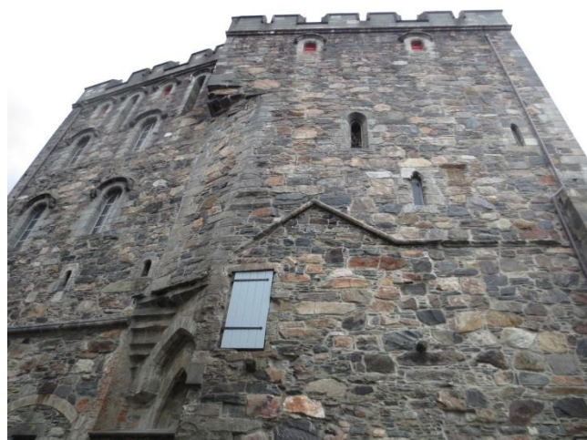
Øvre del av fasade nord, der hele hjørnet mot nordvest (oppe t.h.) er gjenoppbygget etter krigsskaden.
