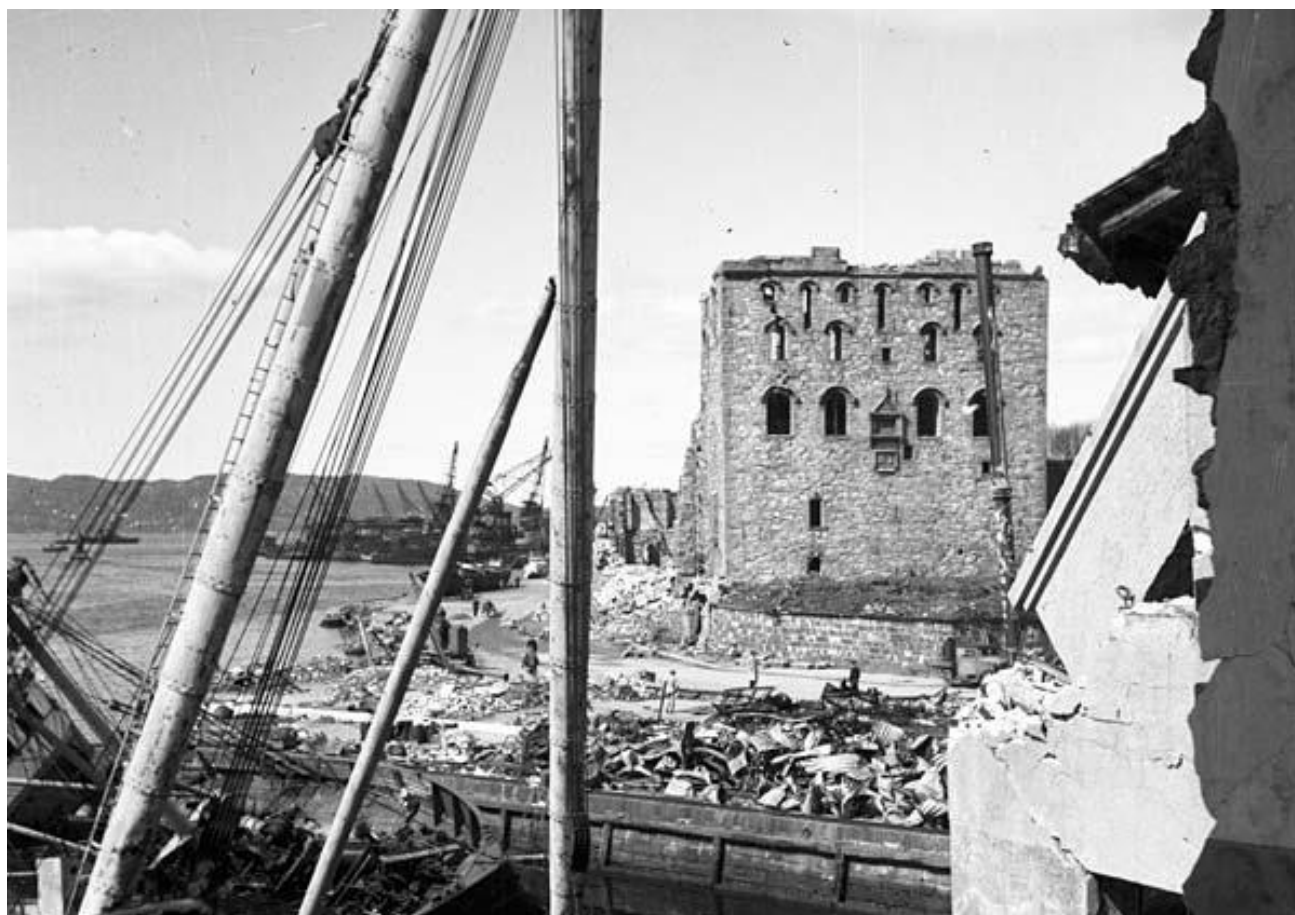
Vågen og Rosenkrantzårnet etter eksplosjonsulykken 20. april 1944. Renaissancefasaden mot sør sto relativt intakt, foruten den murte kreneleringen rundt vektergangen, som i hovedsak var rast ned. Taket var blåst av, etasjeskillene av tre rast ned, og murverket hadde generelt store skader.
