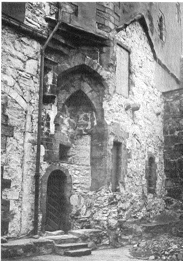
Detalj av nordveggen.
