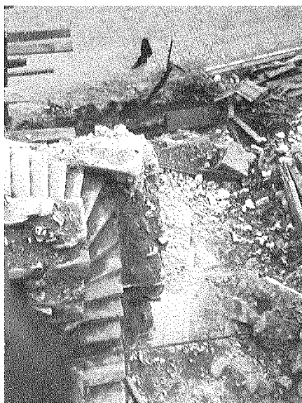
Hjørnet mot nordvest ble hardest skadet (beskåret bilde). Her ses også den innebygde trappen fra Rosenkrantz' tid i samme hjørne.
