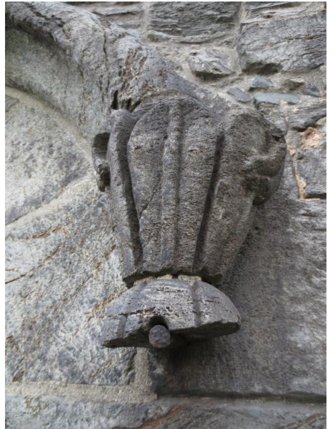
Rustutviklingen og ekspansjonen har økt, med dertil større avstand mellom jern og stein.
