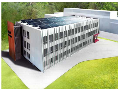
Administrasjonsbygg på Haakonssvern ved utgangen av 2014, og tegning av ferdig bygg.
