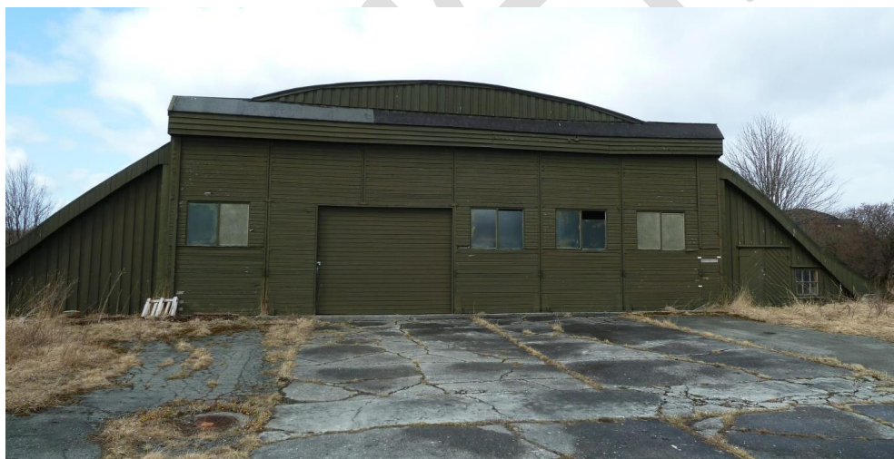
Figur 49. A25. Hangar 1, Messerschmidthangar fra 1945 med betongdekke.
