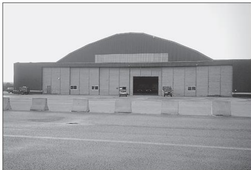
Figur 81: Hangar A (Kilde: Forsvarsbygg)
