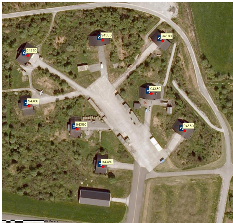
Figur 48. Fredete Messerschmidthangarer innenfor Ørland Hovedflystasjon. Kilde: Riksantikvaren http://askeladden.ra.no .
