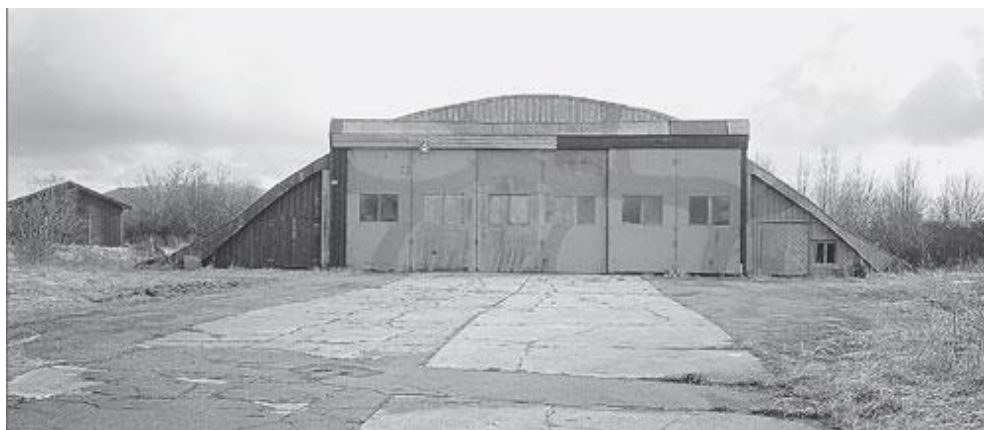
Figur 50: Messerschmidthangarer med opprinnelig banedekke (Kilde: Forsvarets landsverneplan)
