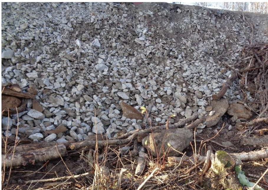
Figur 11 Fyllingsfotens innhold er hovedsakelig pukkk og stein i ulike størrelser.
