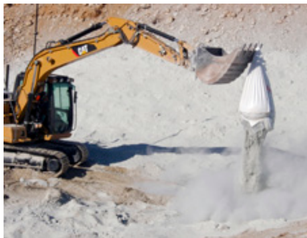
Olivin for forurensningssikring legges ut i massedeponi på Storranden.
