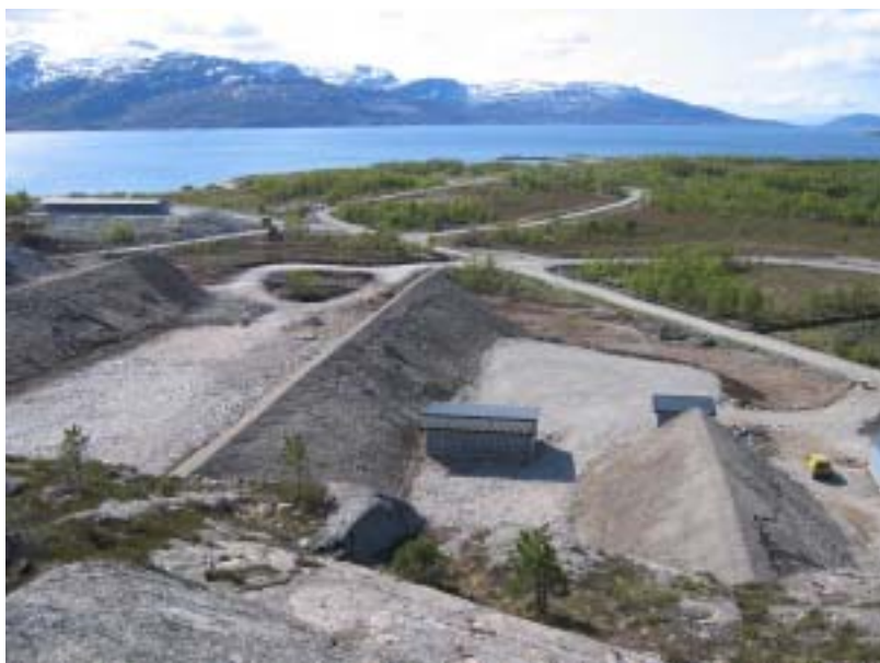
Figur 5 Bildet viser bane 2 og 3 på Ramnes. Bane 2 har skytebanehus. Øverst til venstre i bildet ser vi skytebanehuset på bane 5.
