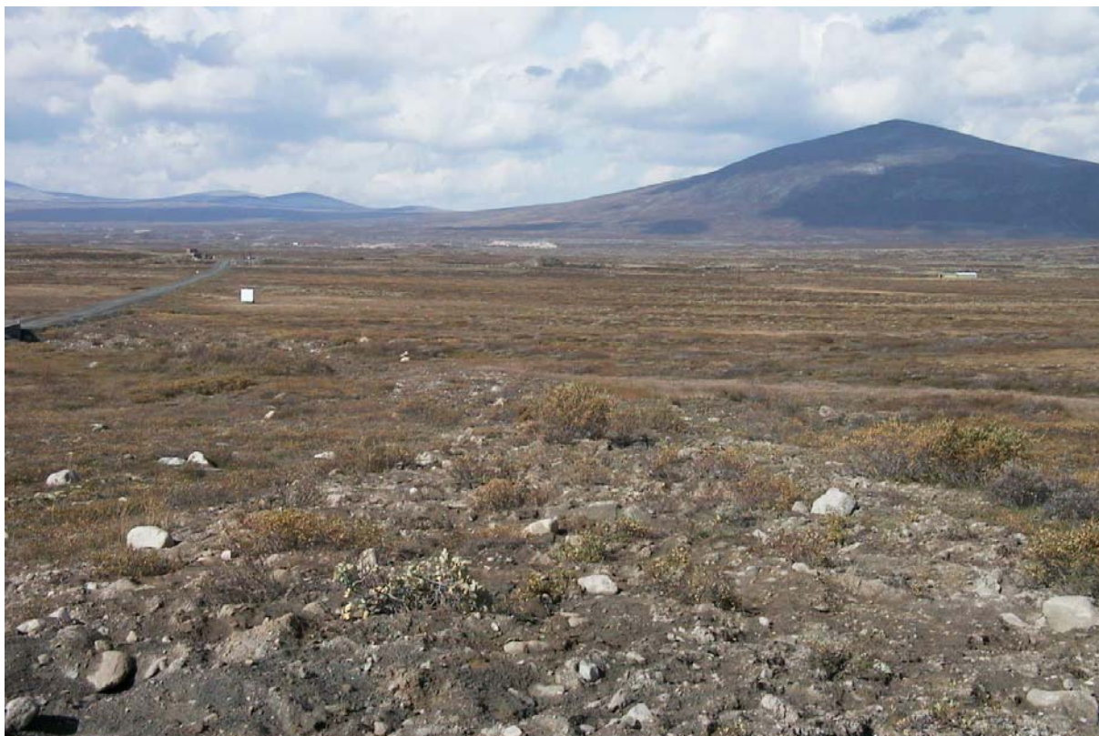
Vier etter istandsetting på strekning hvor en har lagt ut tuer med vegetasjon og stein fra sideterrenget.
