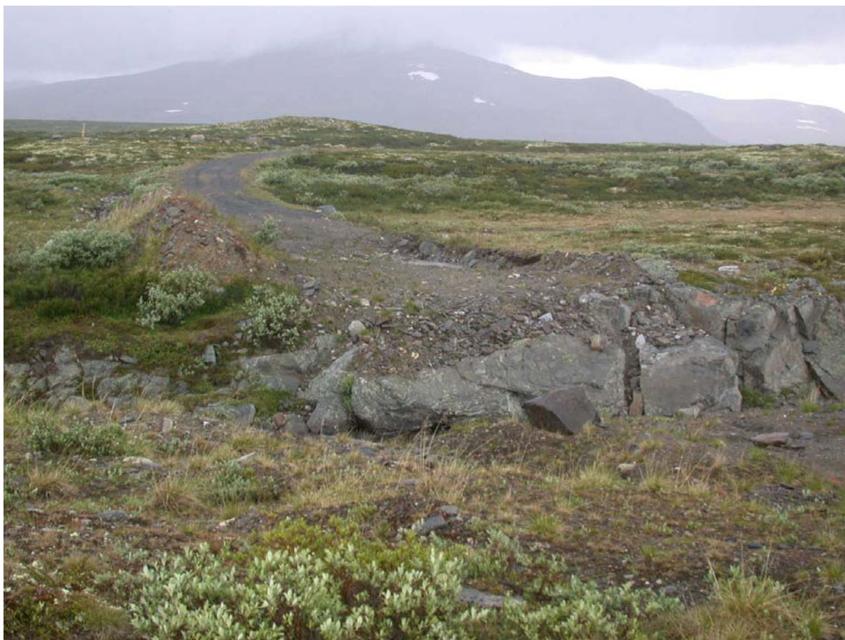
Bjønbrodd nord før: Vegen ligger helt ut mot elvebredden.
