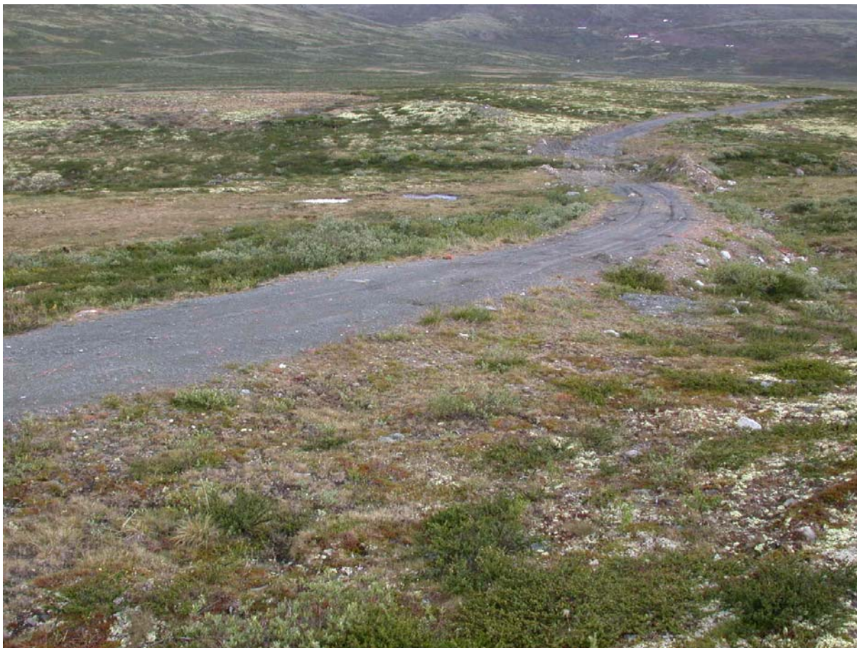
Bjønbrodd nord før: før vegen når elvebredden går den på fylling over et myrområde.
