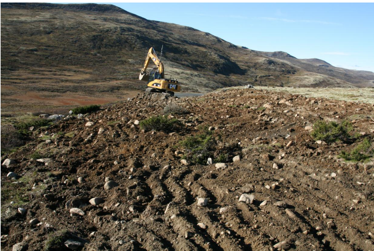
Figur 8 Tverrfjellvegen fjernes Foto: Odd-Erik Martinsen / Forsvarsbygg
