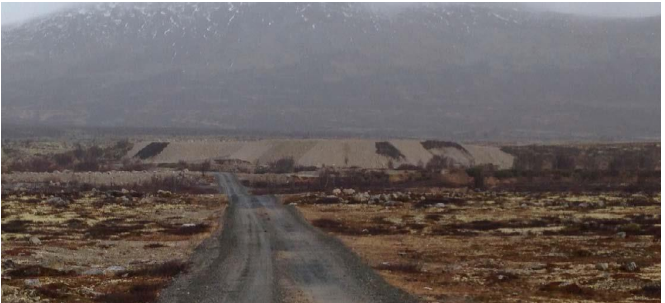
Foto 3. Fotografi av Storranden oktober 2014 etter at myrjord ble fordelt ut på 4 områder, totalt et areal på 660 m 2 (Hagen, D. og Evju, M. NINA 2014). Områdene med myr synes som svarte felter i deponiet, hvorav de 3 største områdene utgjør ca. 200 m 2 hver. Bildet er tatt av Frode Nyhagen (Forsvarsbygg).
