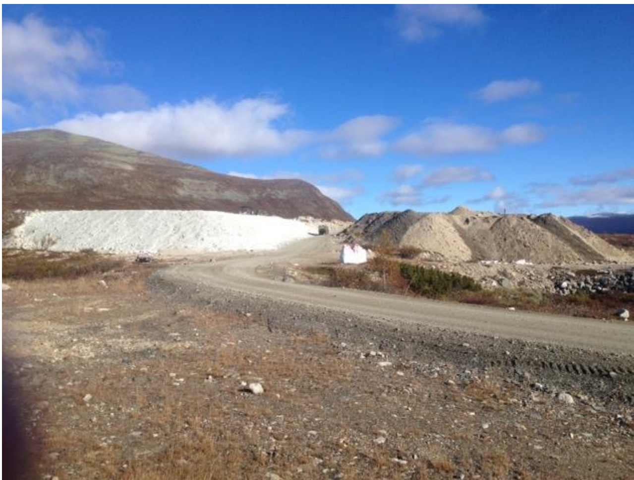
Figur 14 Deponi M3 på Storranden klarlagt for toppdekke (til venstre) og under oppfylling (til høyre)
