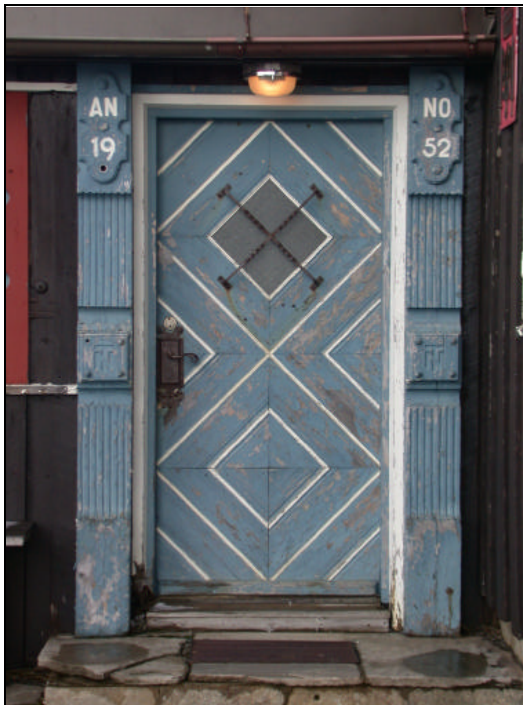
Figur 9 Inngangsdøren til Snøheim
