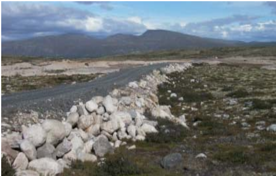
Steinfyllinga sett mot nordvest. Fyllinga oppleves skjemmende i nærvirkning.
