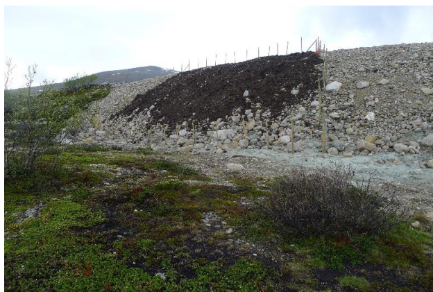
Figur 4 Skråningene på Storranden ble påført jord (t.v., et av fire felter der det er påført myrjord). Vier som var oppformert fra morplanter i skytefeltet ble plantet ut i myrjorda i juni 2015.
