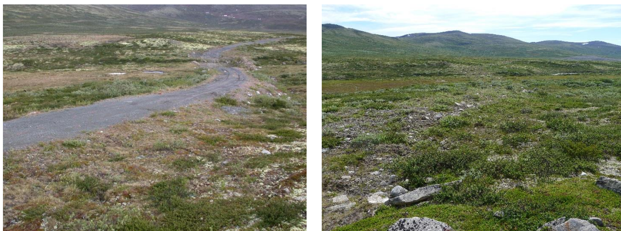
Figur 8 Tilbakeført veg på Hjerkin, som del av Pilotprosjektet (strekningen kalles Bjønnbrodd), før fjerning av vegen (t.v., år 2002) og etter 13 år (t.h., 2015).
