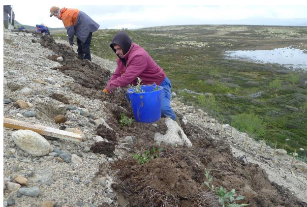
Figur 4 Skråningene på Storranden ble påført jord (t.v., et av fire felter der det er påført myrjord). Vier som var oppformert fra morplanter i skytefeltet ble plantet ut i myrjorda i juni 2015.
