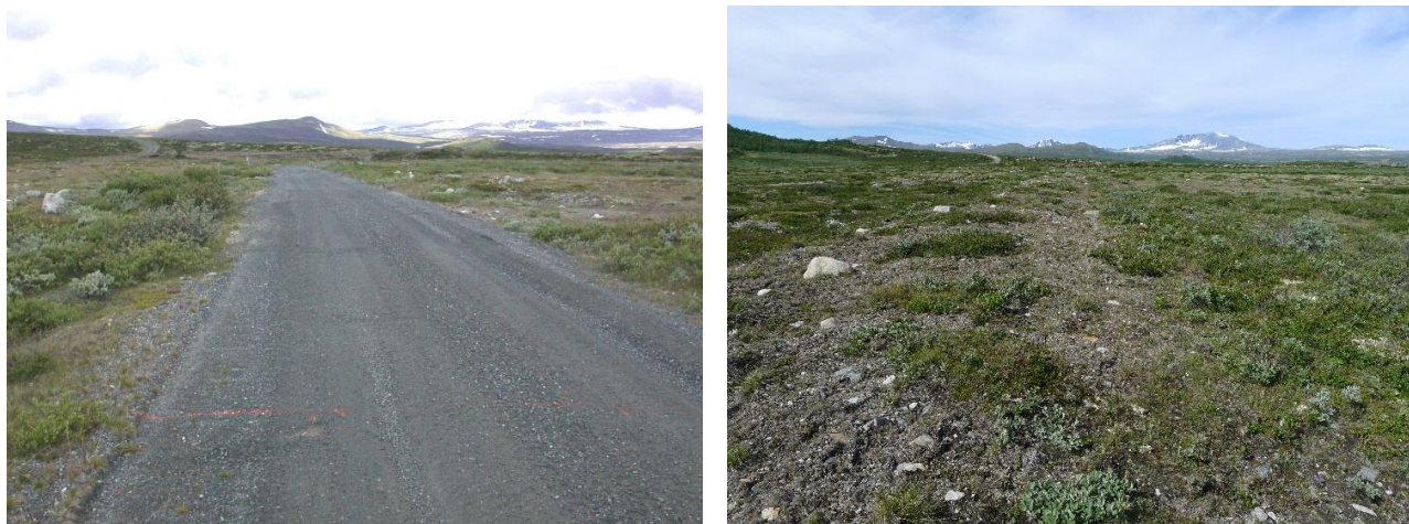
Figur 7 Tilbakeført veg på Hjerkin, som del av Pilotprosjektet (strekningen kalles Mogop), før fjerning av vegen (t.v., år 2002) og etter 13 år (t.h., 2015).
