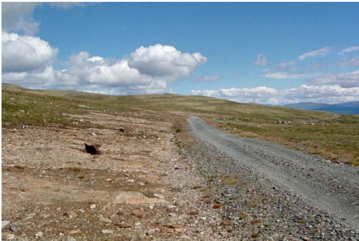
Figur 8. Inngrep langs Ringveien under Vålåsjøhøi, sett mot øst.
