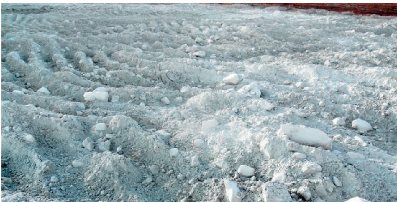
Fig. 46. Bearbeidet overflate dekket med ett lag olivin. For å få tilstrekkelig tykkelse på olivindekkeet (ca. 1 cm) måtte det legges ut 4 - 5 lag.
