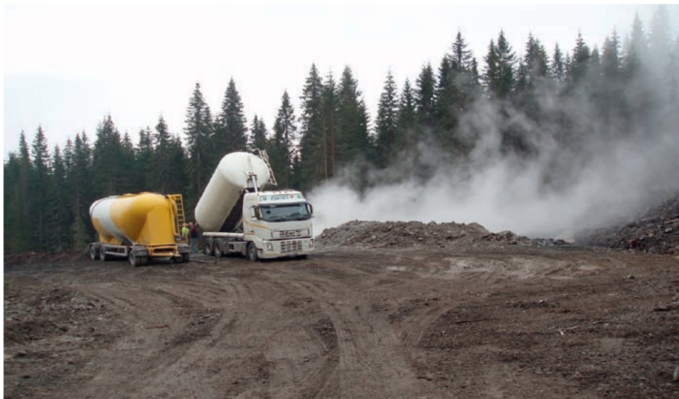
Fig. 57. Olivinlaget på toppen av Styggdalsdeponiet ble blåst ut direkte fra tankbil. Metoden er velegnet for utlegging av olivin på skytevoller, men er tidkrevende og tungvint ved utlegging av tykke lag på store flater. Metoden som er vist på fig. 58 er mer hensiktsmessig og sikker.
