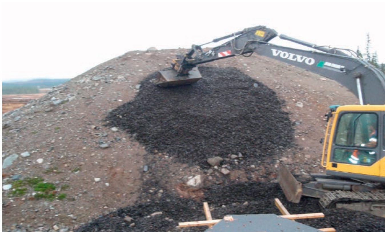
Fig. 65. Utlegging av multiklipp på skytevoll i RØ. Utleggingen var en meget enkel prosess.
