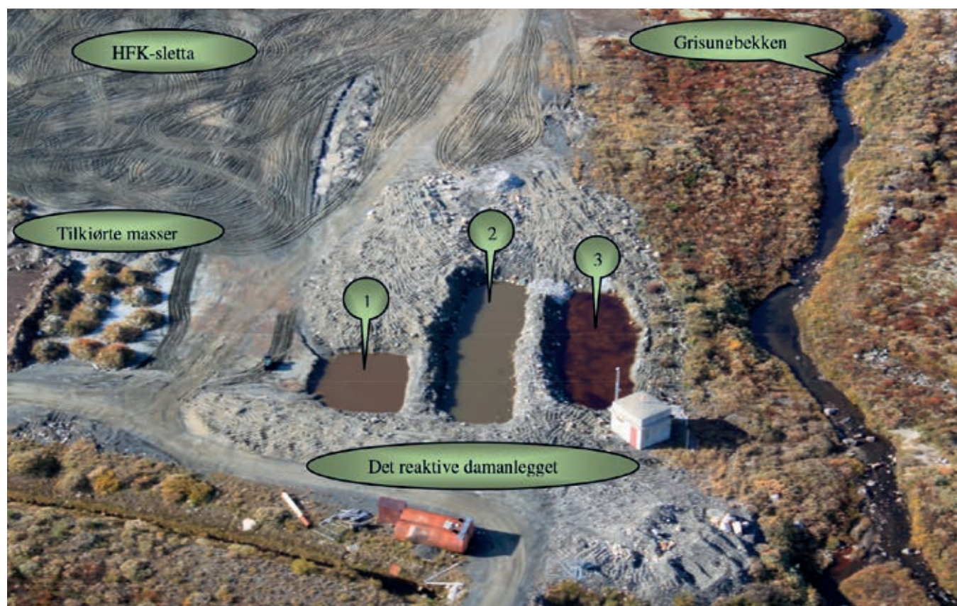
Fig. 39. Det reaktive damanlegget på HFK-sletta. Dam 1 er en sedimentasjonsdam for grovkornete sedimenter, dam 2 er en tilsvarende dam for finsedimenter og dam 3 er en poleringsdam med Blueguard olivingranulat som reaktivt bunndekke. Legg merke til fargeforskjellene som avspeiler kornstørrelsen på sedimentene i dammene. Brunfargen i poleringsdammen skyldes utfelling av jern på granulatet. Sammen med jernet felles også andre tungmetaller.
