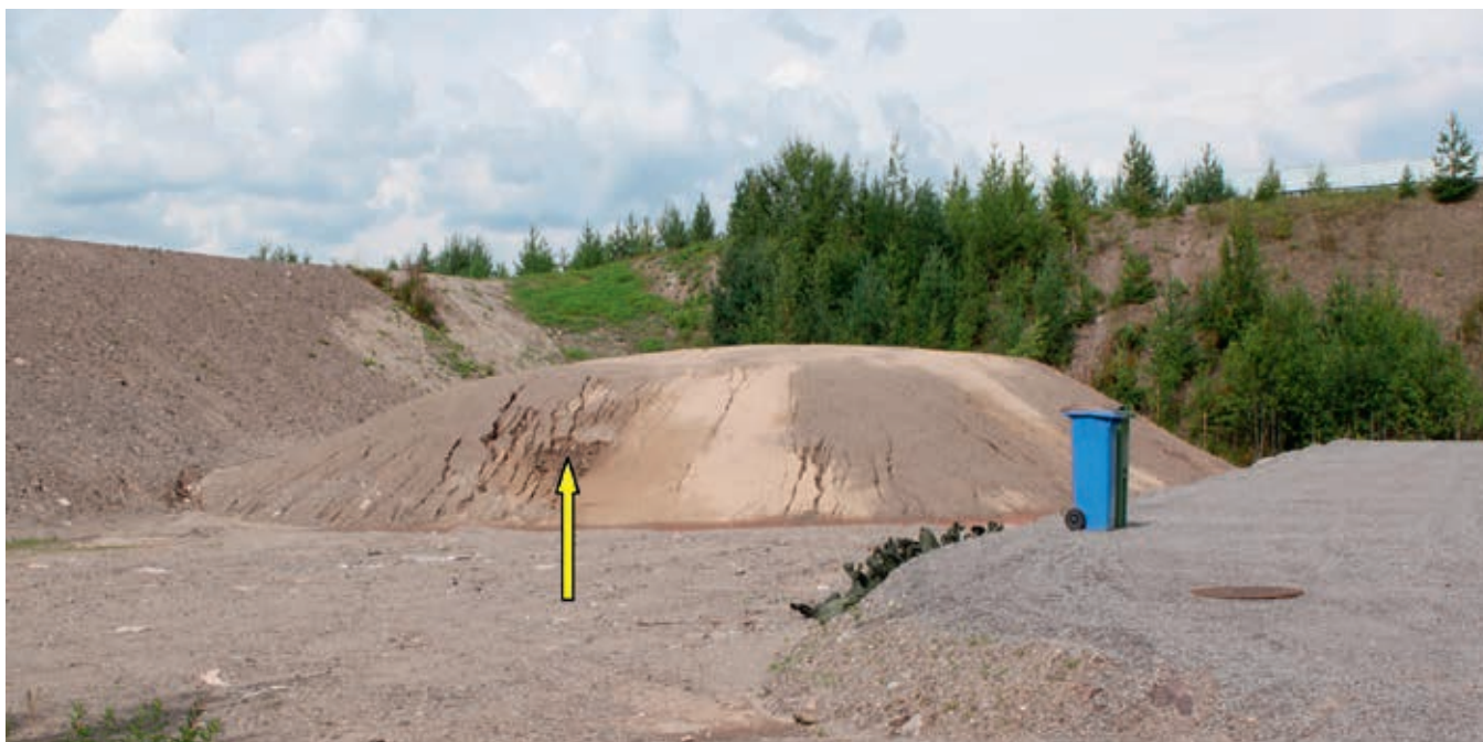
Fig. 60. Deponiet for fangvollmasser i Rena leir. Det er benyttet ensgradert sand som dekkmasser. Da sanden er erosjonssvak er den dårlig egnet til dette formålet. Den gule pilen peker på erosjonsskader etter en nedbørsepisode.
