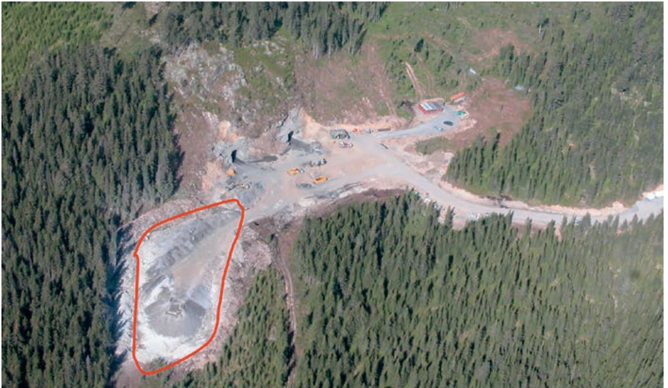
Fig. 55. Fjellhallene for ammunisjonslageret i Styggdalshaugen under utsprenning. Deponiområdet for blyholdig materiale er ringet inn med rødt.
