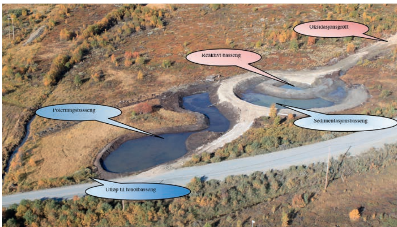
Fig. 40. Det reaktive damanlegget for Tverrfjellet gruve. I oksidasjonsgrøfta oksideres toverdug jern til treverdug og danner fnokker som bunnfelles i sedimentasjonsbassenget. Fra sedimentasjonsbassenget renner vannet over i det reaktive bassenget hvor felling av sink skjer. Siste trinn i tungmetallrensingen er poleringsbassenget. Fra poleringsbassenget renner vannet til et fenolbasseng ved Hjerkinndammen.
