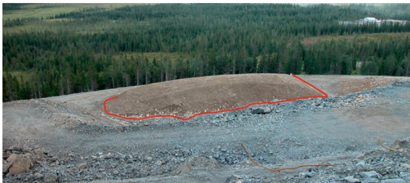
Fig. 54. Deponiet i Deiffellet etter at toppdekket med tett morene var lagt på. Totalt ble det lagt 5 000 m 3 blyholdig masse i deponiet. Gjennomsnittlig blyinnhold i svartskiferen var > 500 mg/kg.
