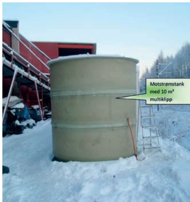
Fig. 37. Motstrømtanken ved Oppland Metall under bygging. For å beskytte mot frost ble det lagt en varmekabel i spiral rundt tanken før den ble dekket med vintermatter.
