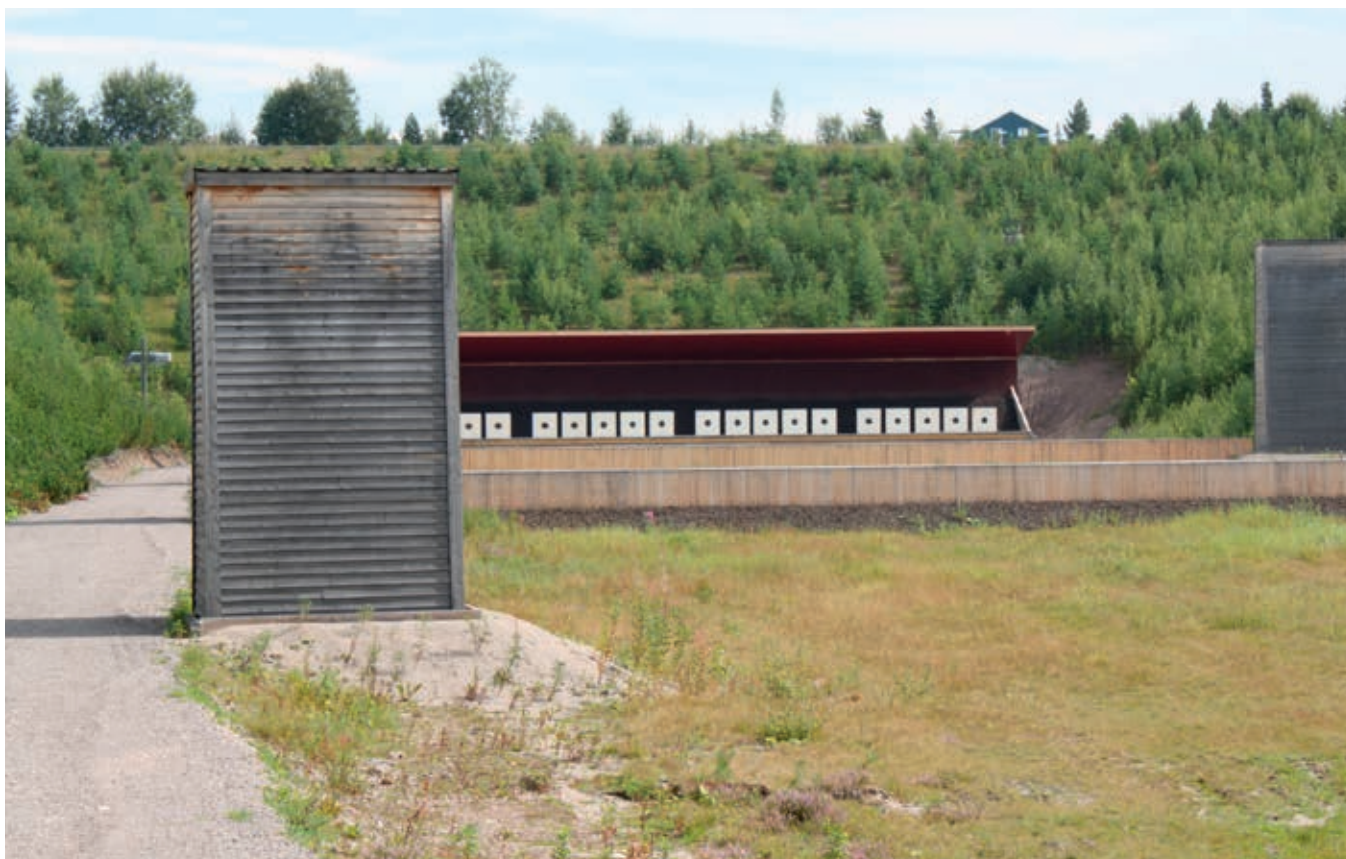
Fig. 71. Bane 4 i Rena leir. Dekk-klippet ligger under tak som beskytter mot nedbør og avrenning. Ulempen med løsningen er at dekk-klippet tørker ut slik at brannfaren øker.
