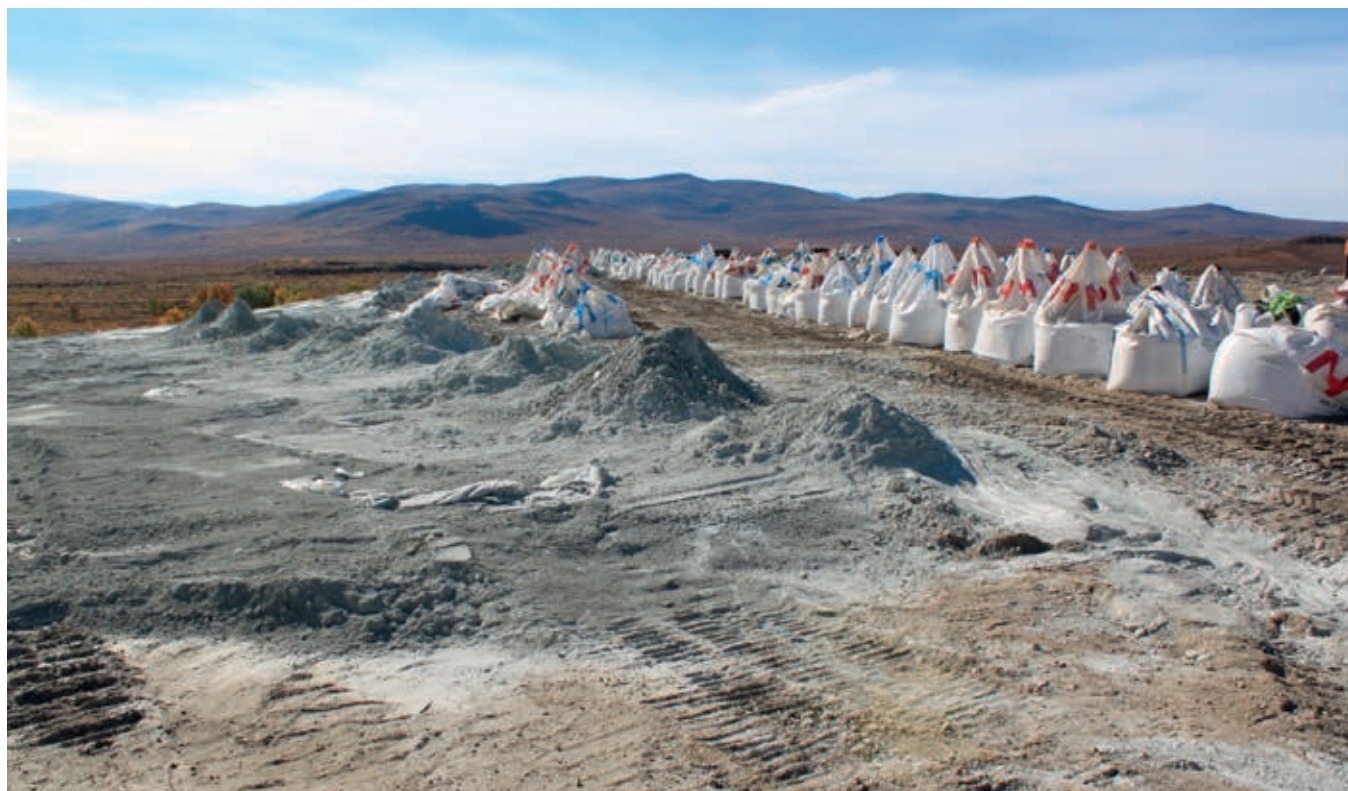
Fig. 58. Bildet viser utlegging av olivindekke på deponiet på Storranden. Storsekkene settes ut med intern avstand som avpasses etter hvor tykt olivinlaget skal være. Sekkene spjæres og olivinen jevnes ut med doser.
