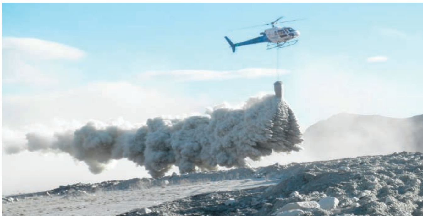
Fig. 45. Utlegging av olivin på HFK-sletta skjedde med stor presisjon.
