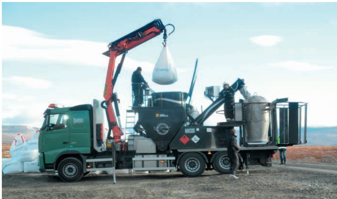
Fig. 44. Bakkestasjonen hvor fyllingen av Blueguard 63 i "bottene" som helikopteret brukte til spredning. Det tar mindre enn 1 minutt å klar- gjøre ny bølge med ett tonn Blueguard for avhenting
