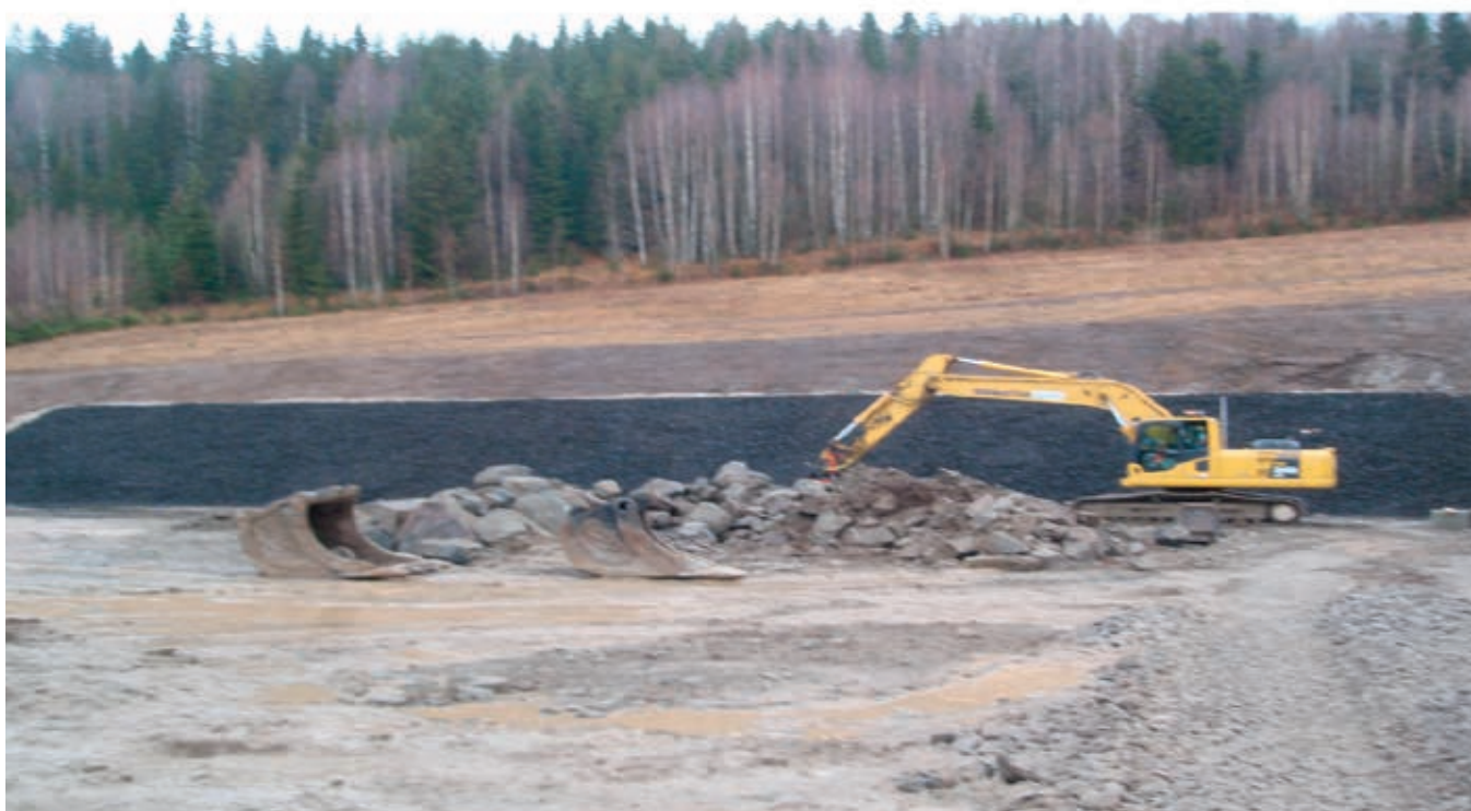
Fig. 70. Vollen på én av kortholdsbanene på Rødsætra under bygging.
