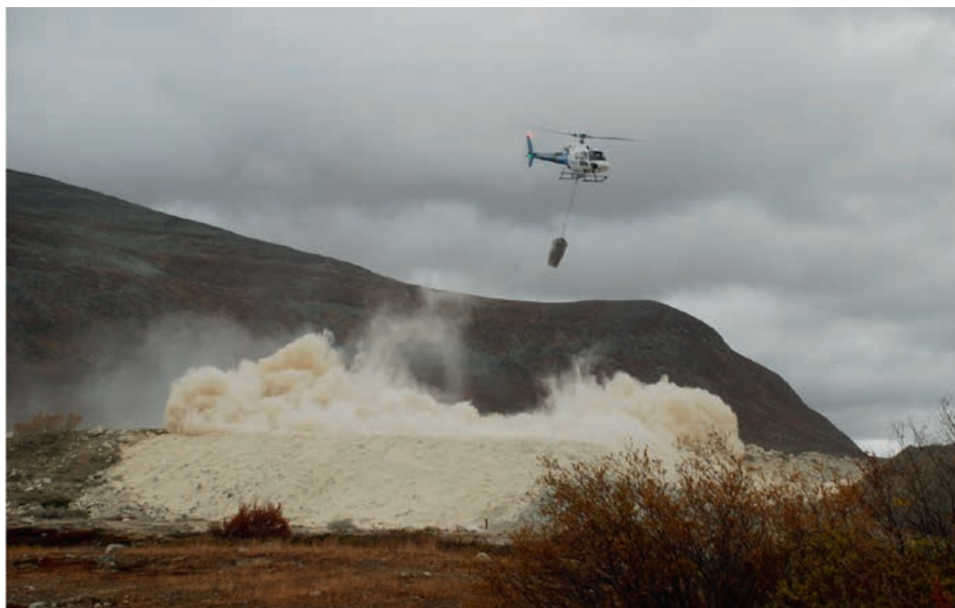
Fig. 50. Utlekkingen av bentonitt ble gjort med helikopter. (Foto Svein Solli).
