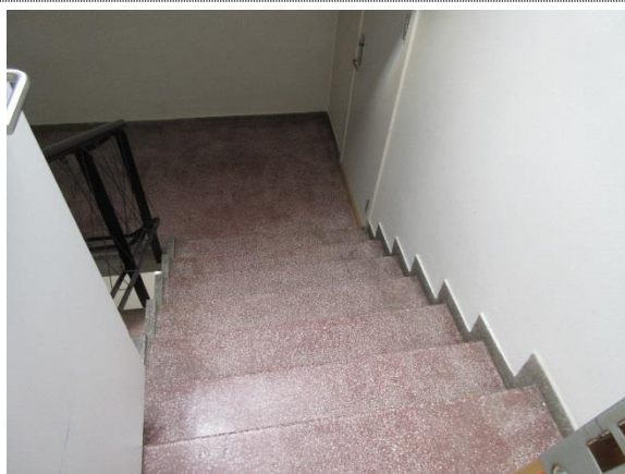
Bilde nr. 139 Betongtrapper med rødt terrazzobelegg.
