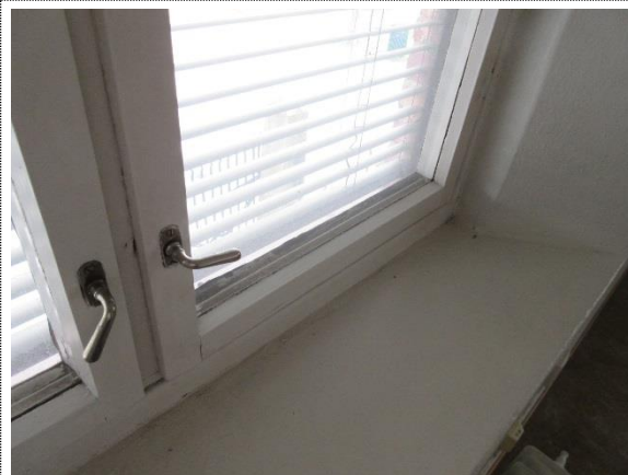
Bilde nr. 142 Gamle, koblede trevinduer trolig fra 195-tallet.
