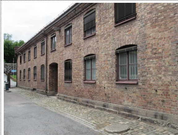
Bilde nr. 122 Østfasade sett mot sør.
