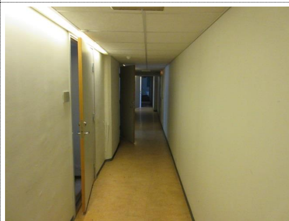
Bilde nr. 34 Det er også montert noe nedforet T-profil himling i korridorer i 1. etasje.
