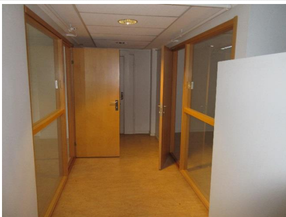
Bilde nr. 77 Cellekontorer fra 1980-tallet i 2. etasje.
