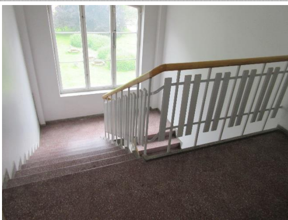
Bilde nr. 75 Betongtrapp i midttårnet.
