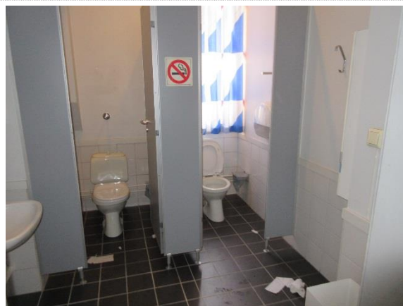
Bilde nr. 30 Relativt moderne WC i 2. etasje.
