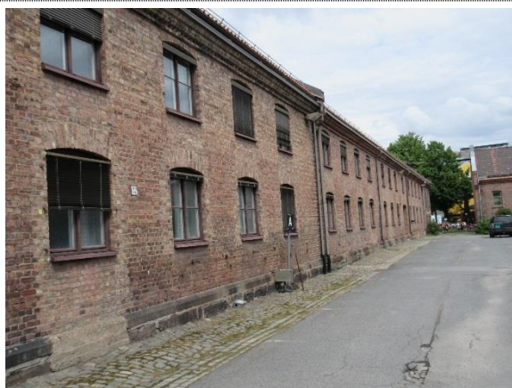
Bygg 32 - bilde nr. 121 Østfasade sett mot nord.
