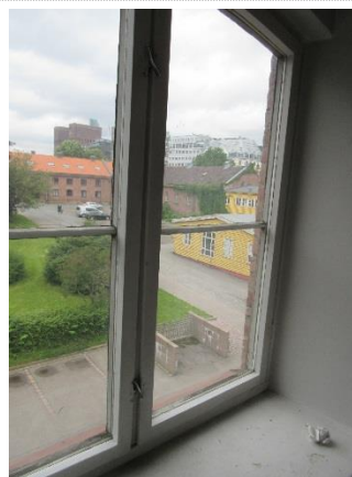
Bilde nr. 78 Gamle, koblede trevinduer trolig fra 1950-tallet.
