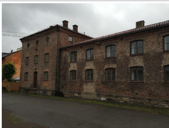
Bygg 30 – bilde nr. 55 Her fra vestfasaden mot nord.
