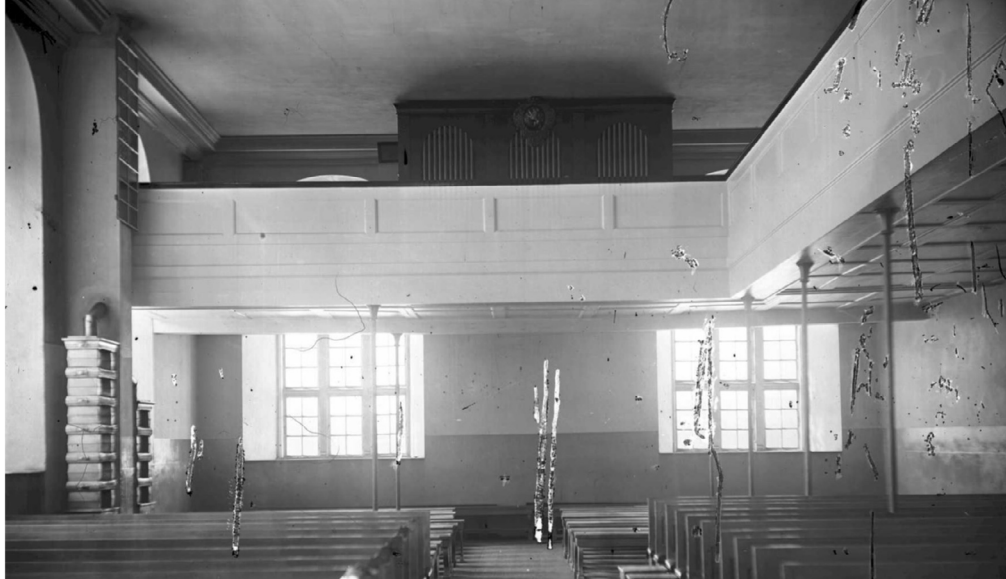
Fig. 1 Albrechtsen-orgelet i Garnisonskirken på Akershus. Orgelet hadde spillebordet på siden og trespiler som illuderte attrapp-piper i fasaden. Takhøyden på galleriet var så lav at Bassoktaven til Principal 8' hadde dekte piper av tre. Foto: Ole Tobias Olsen ca. 1875, Byhistorisk samling, Oslo museum http://oslobilder.no/OMU/OB_OT389
