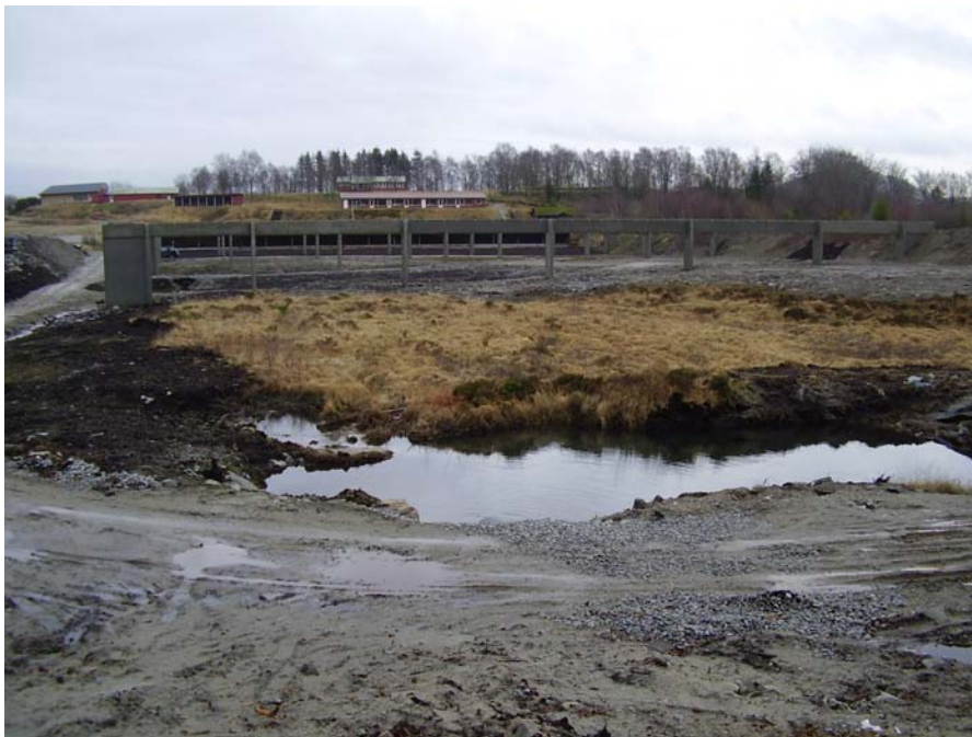
Figur 79 Dam nedstrøms kulefangervoll Vatneleiren
