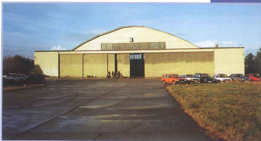
Hangar Lista Flystasjon
