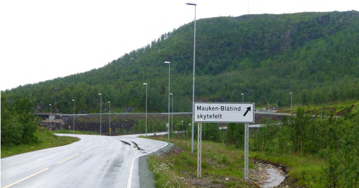
Figur 14: Når man kommer sørfra på E6 gjelder det samme som fra nordsiden. Kun av- og påkjøringsrampene er synlige, samt selve brua. Fjellet vi ser på bildet er Falkefjellet. Bildet er tatt ved UTM 33, Ø: 657735 N: 7672532
