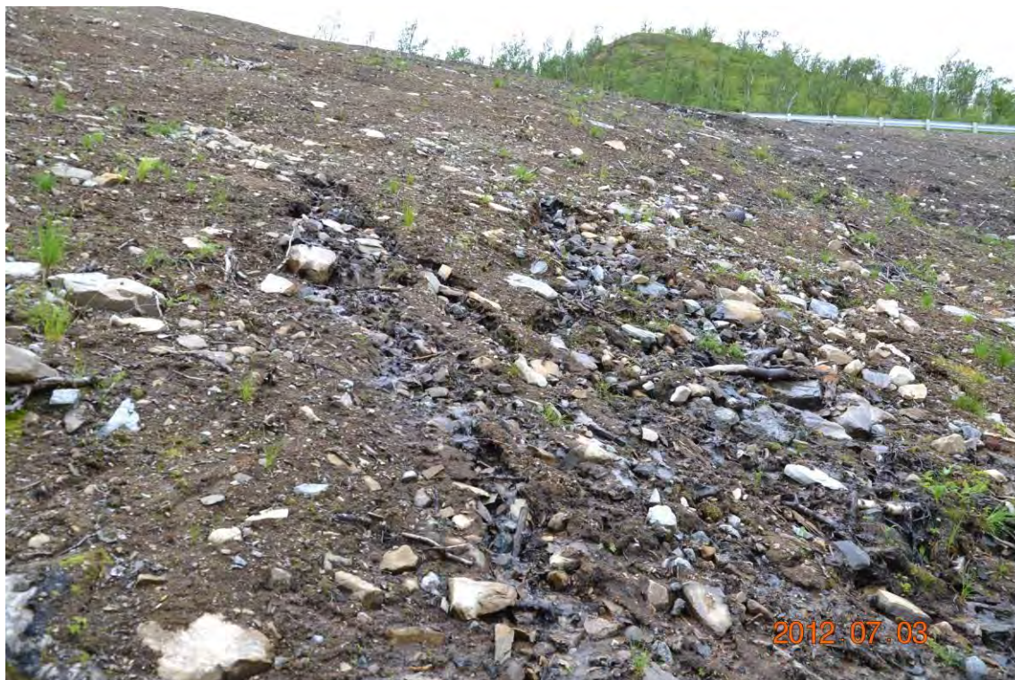
Figur 7. Sigevann i forkant av steinfylling. Vannkvaliteten har samme fingeravtrykk som bekken utenfor tunellen. Påviste metaller i analysene stammer fra naturlige malmforekomster.
