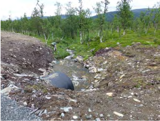
Figur 15: Mye bar jord i skråningene ned mot det midtre løpet av Bergelva langs sammenbindingstraséen. Det anbefales å så til med norsk fjellfrø for å fremskynde revegeteringen.
