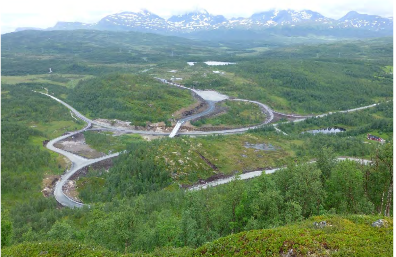
Figur 12: Bildet over viser østsøyfen, med av- og påkjøringsrampene brua og oppstillingsplassene for kjøretøy. Bildet er tatt fra Falkeberget og vestover mot Blåtind skyte- og øvingsfelt. Foto tatt 3. juli 2013.
