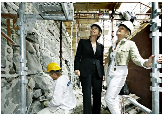
Sikring av murene på Akershus festning. Foto: Forsvarsbygg
