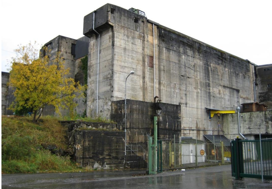
Ubåtbunkeren Bruno i Laksevåg
