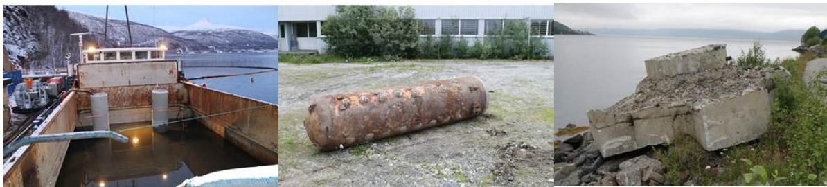
14.1. Bildet til venstre viser oppsugingen av masser fra sjøbunnen. Bildet i midten viser den ene av de to russiske lyttebøyene som ble fjernet. Bildet til høyre viser en oppgravd skytestilling. Denne ble knust, og ren betong ble lagt i eksisterende utfylling mens armeringsjern ble sendt til deponi.
