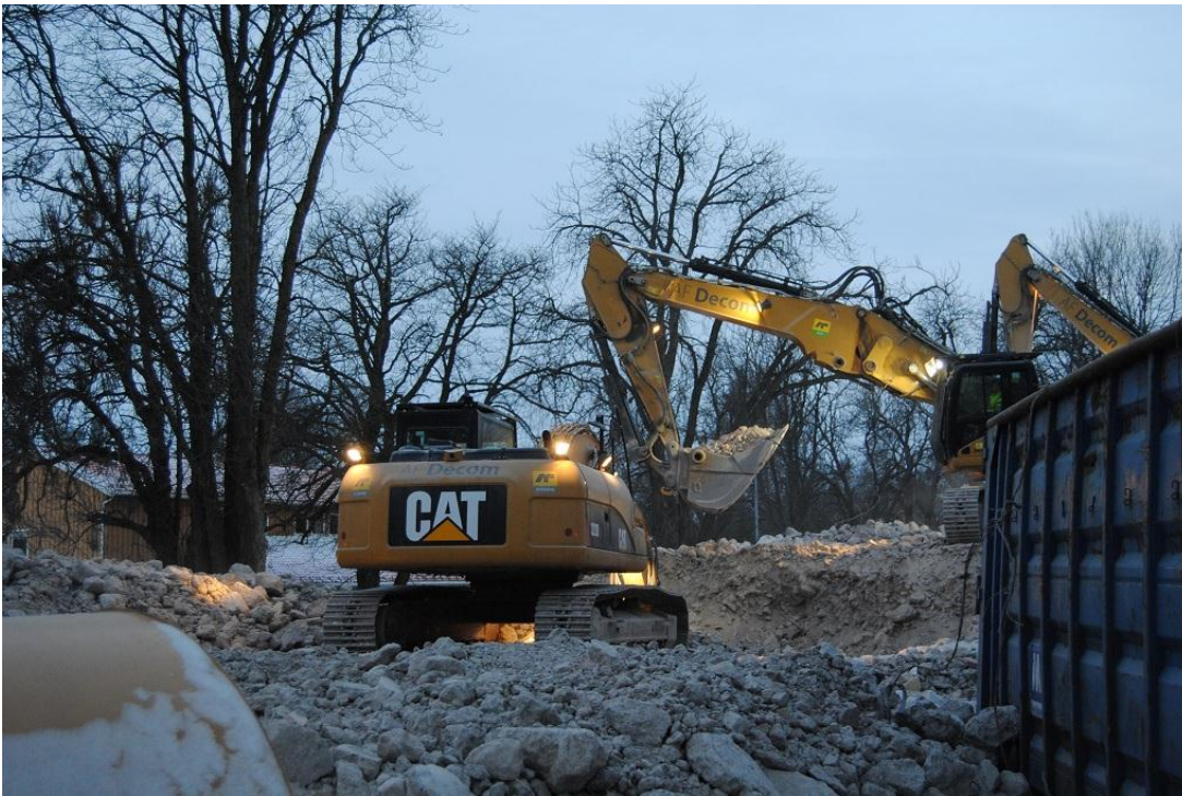
To meter tykke betongvegger ble revet ned under arbeidet med å fjerne den gamle bunkersen på Karljohansvern Foto: AF Decom
