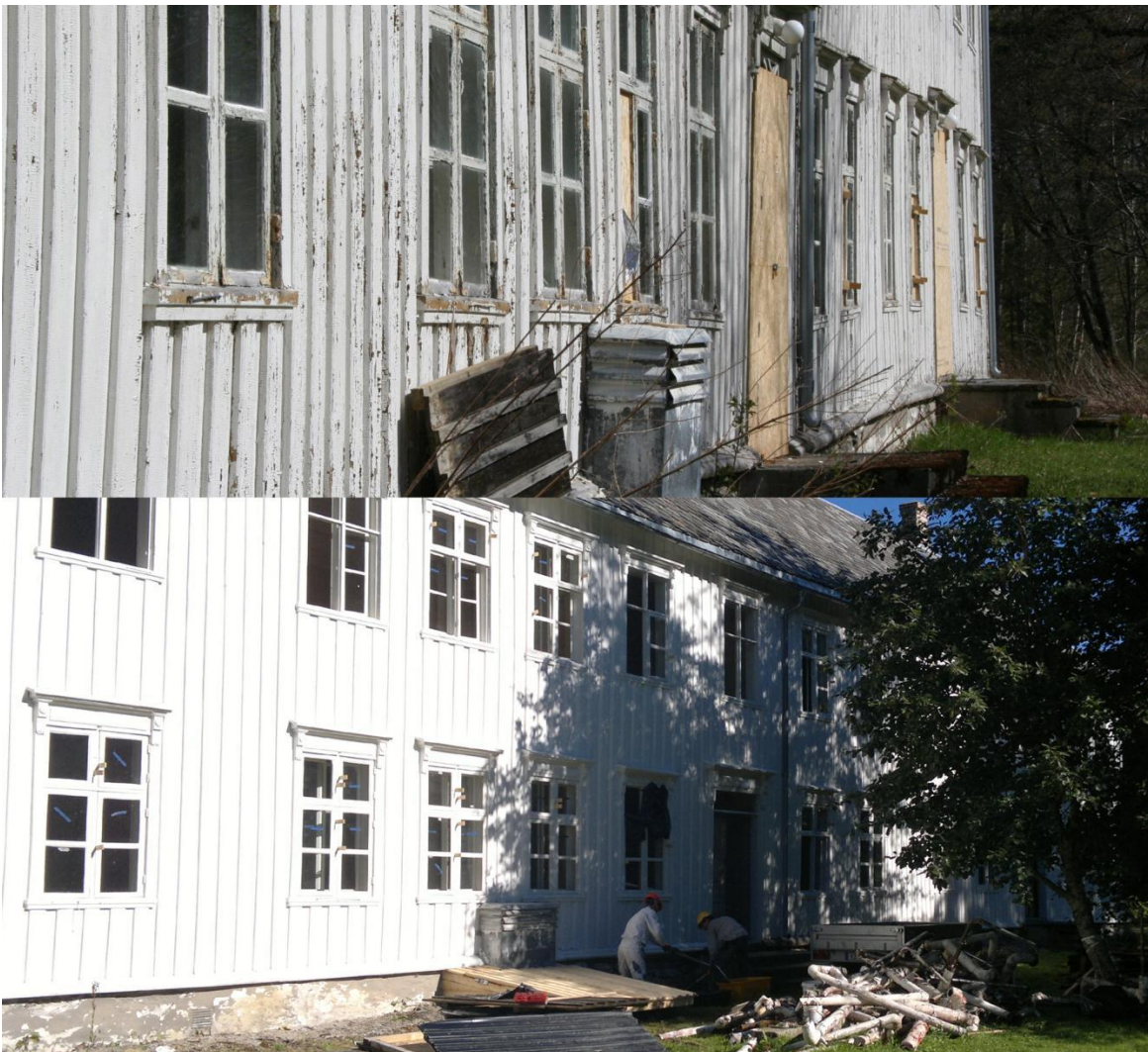
Den fredete hovedbygningen på Værnes hovedgård ble rehabilitert utvendig. Foto: Tine Poppe
