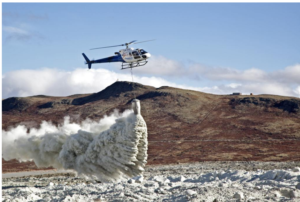
Bilde: Spredning av olivin over HFK-sletta for å forebygge utlekking av tungmetaller. Foto: Geir Olav Slåen / Forsvarsbygg.
