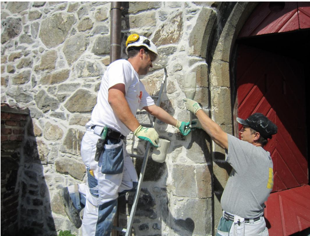
Fra arbeidet på Sydføyen, Akershus festning. Rundt den gamle Hovedporten fra ca år 1300 hadde skader og store hulrom på baksiden som følge av frostsprenging. Her valgte man å gyse inn flytende kalkmørtel for ikke å endre den opprinnelige strukturen.
