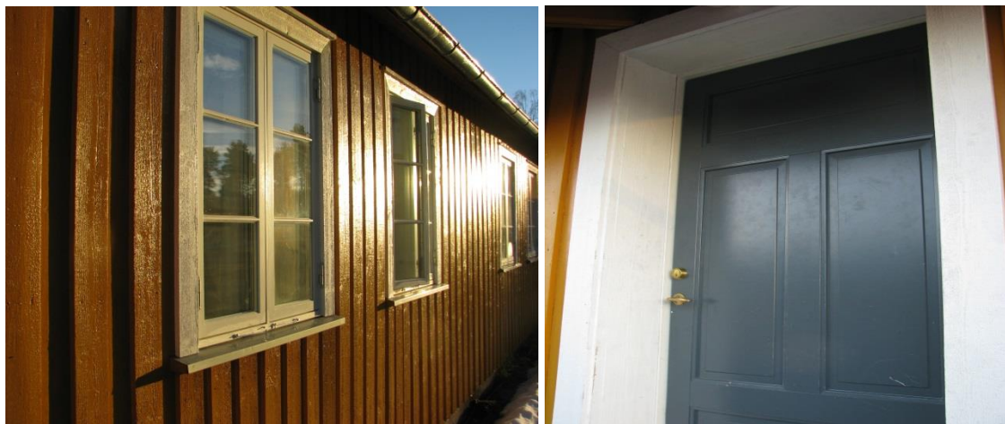
Rehabilitererte mannskapsforlegninger på Terningmoen
