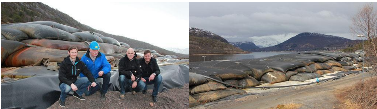
Bilde: Deler av de involverte i prosjektet samlet foran geotuber på land. Bilde til høyre viser noen av geotubene som ligger til tørk. Foto: Beate Ingebrigtsen, Forsvarsbygg.
