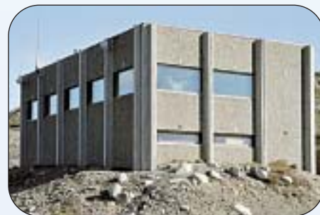
Skytelederhuset på Haukberget er et eksempel på et bygg som det er greit å rive og fjerne fra Hjerkinnskytefeltet.
