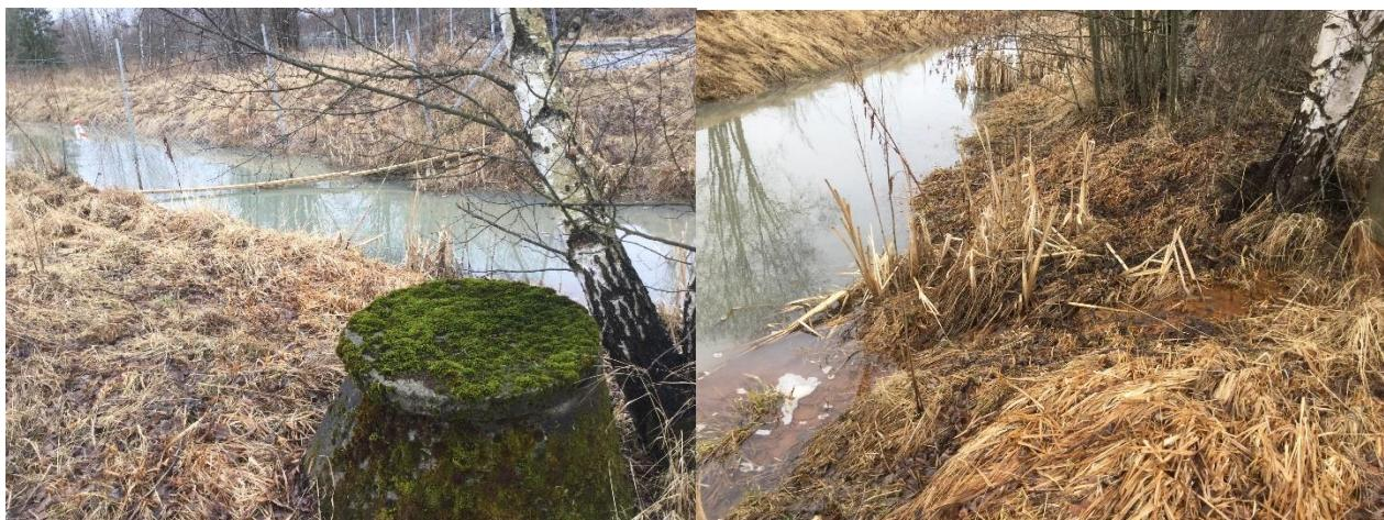
**Figur 8:** Til venstre vises kum ved avfallsfylling. Til høyre vises avrenning fra kum mot Sogna.
