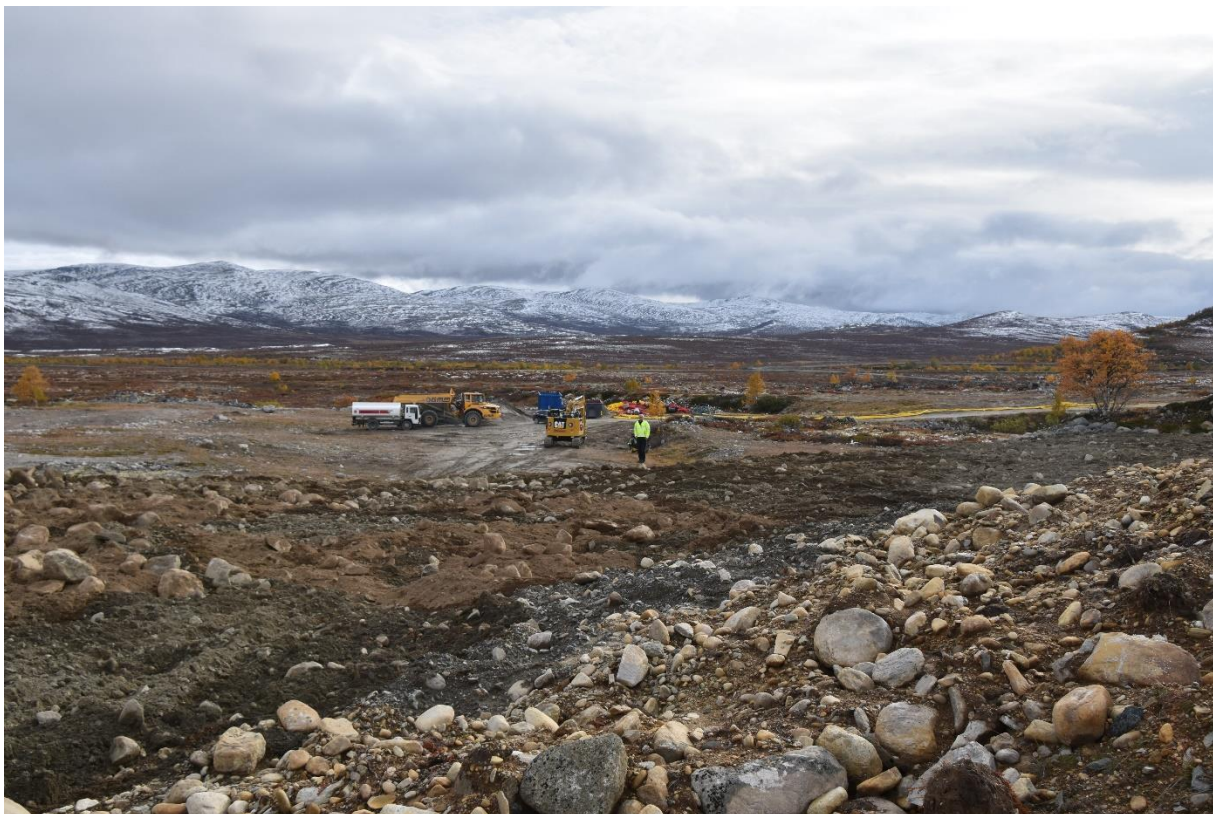
Figur 17. I 2017 ble det kjørt overskuddsmasse fra Haukberget og HFK-veien til M1 på Storranden.
