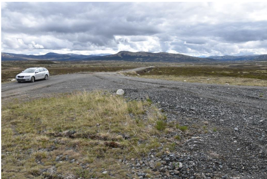
Figur 14. Deler av standplass og indre deler av veien til Haukberget II før oppstart av anleggsarbeid, juni 2017.
