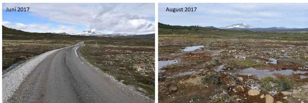
Figur 5. Veien inn til HFK. Bildene viser en vegstrekning som ble fjernet med bemannet anleggsmaskin gjennom en mosaikk av lynghei og fuktig grasmark (før fjerning av veg til venstre, etter fjerning til høyre).
