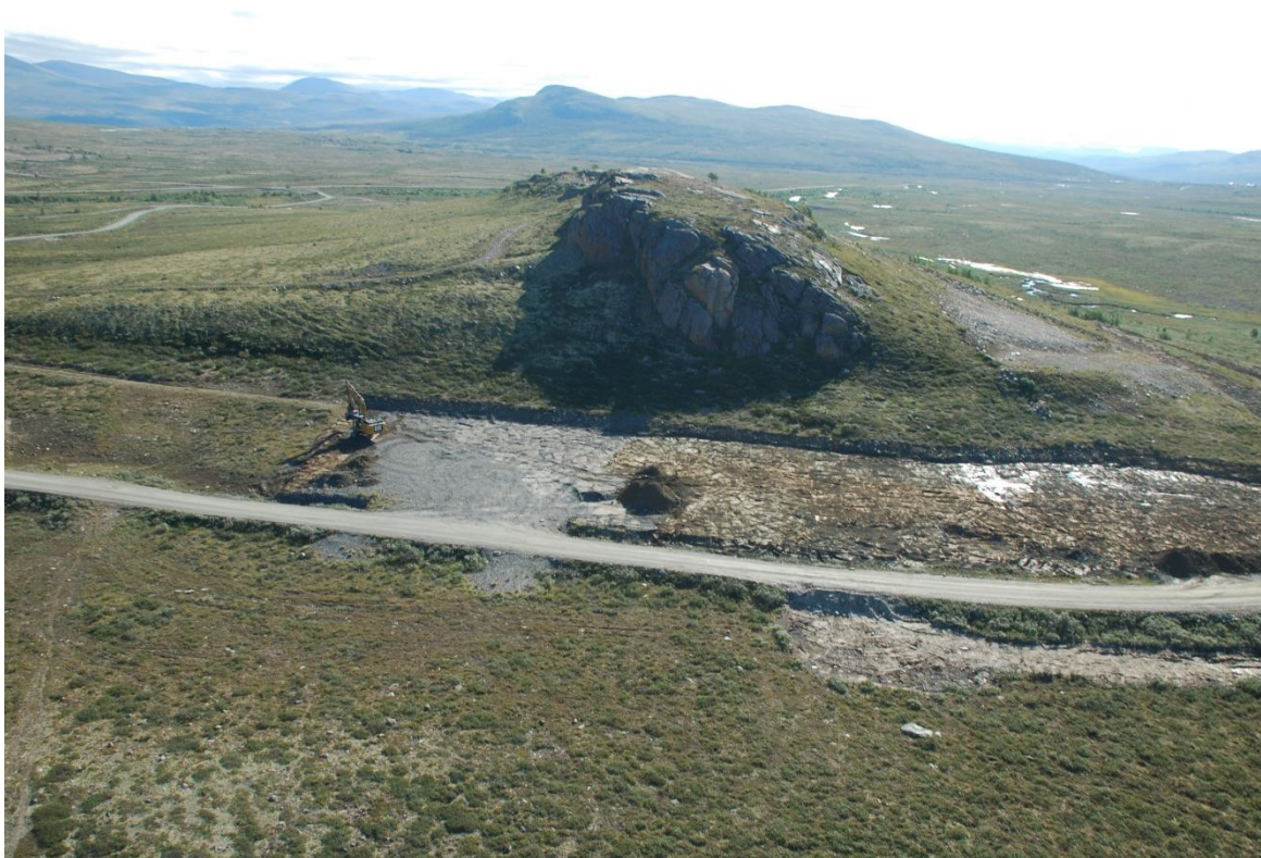
Figur 13. Anleggsarbeidet er i gang på Haukberget I. Tilkjørt pukk og overskuddsmasser ble delvis brukt til terrengforming og delvis transportert til Storranden.
