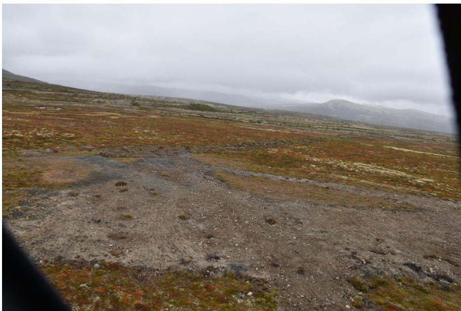
Figur 15. Standplass og indre deler av veien til Haukberget II etter avsluttet anleggsarbeid, oktober 2017.
