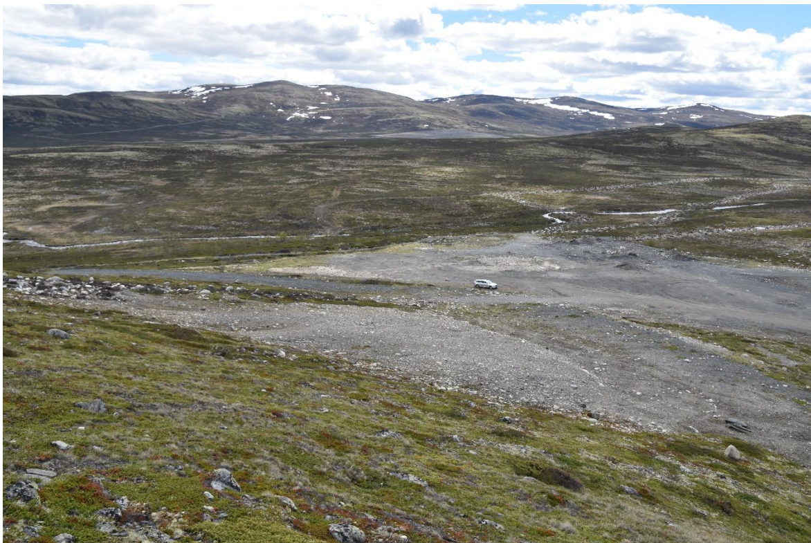
Figur 12. Standplassområdet på Haukberget I er et omfattende og krevende inngrep med behov for store masseflyttinger for å gjenskape et mest mulig opprinnelig terreng og legge grunnlag for langsiktig vegetasjonsetablering.
