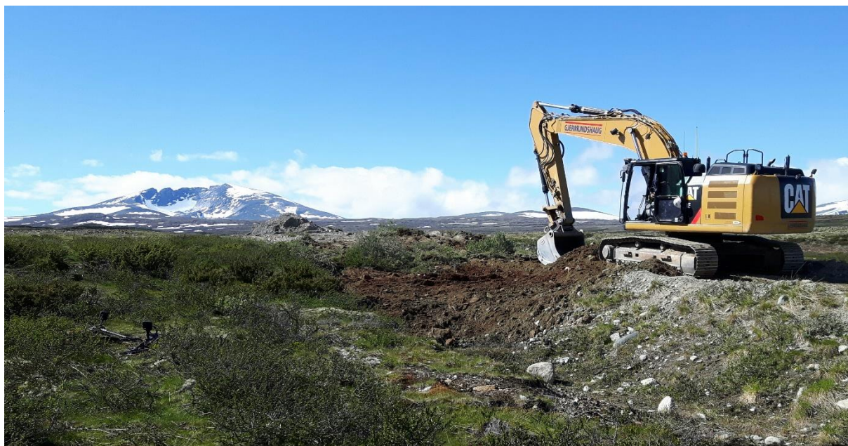
Figur 11. Siste rest av skytefeltanleggene på Haukberget ble fjernet i 2017. Veien til Haukberget II var bred og med store grøfter der vegmassene kunne plasseres tilbake.
