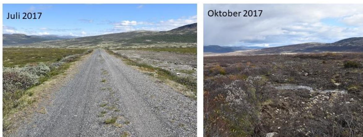
Figur 7. Lille Ringveg (Storrandveien). Bildene viser en vegstrekning som ble fjernet med bemannet anleggsmaskin gjennom en dvergbjørkhei med et fuktig drag (før fjerning av veg til venstre, etter fjerning til høyre).
