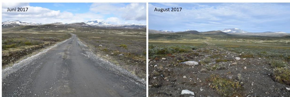
Figur 4. Veien inn til HFK. Bildene viser en vegstrekning som ble fjernet med fjernstyrt anleggsmaskin gjennom fuktig vierhei (før fjerning av veg til venstre, etter fjerning til høyre).
