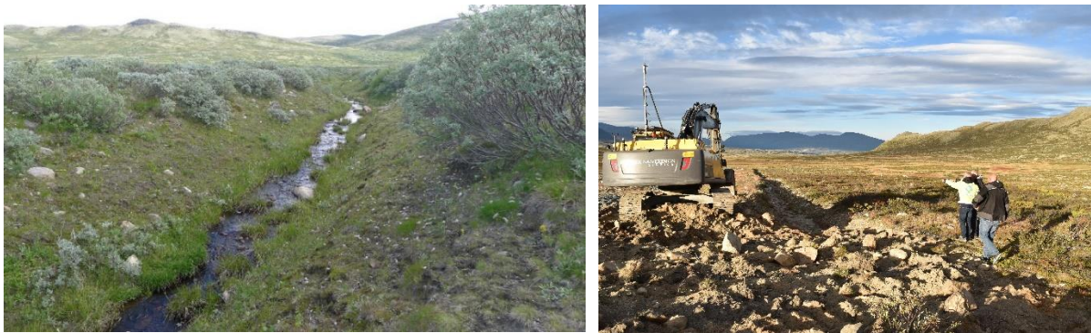
Figur 4 Grøfta før (tv) og under (th) tilbakeføring. Den rette og djupe grøfta rammet inn HFK-sletta og forsterket inntrykket av den avvikende formen i terrenget. Foto: NINA
