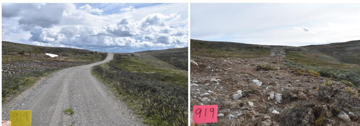
Figur 16: Veien var lagt i fylling opp til ryggen i bakgrunnen. Massene ble tatt ned til terreng og ryggen har fått tilbake sin opprinnelige form.
