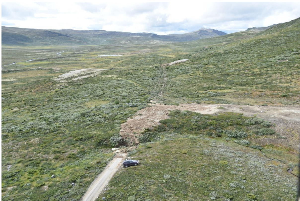
Figur 21: Deler av strekningen i Grisungdalen har frodig vegetasjon som forenkler revegeteringa, men samtidig er det stedvis svært tørre og vanskelige masser som er krevende for terrengforming. Bildet viser et pågående anlegg der vegen er fjernet innenfor bekken.
