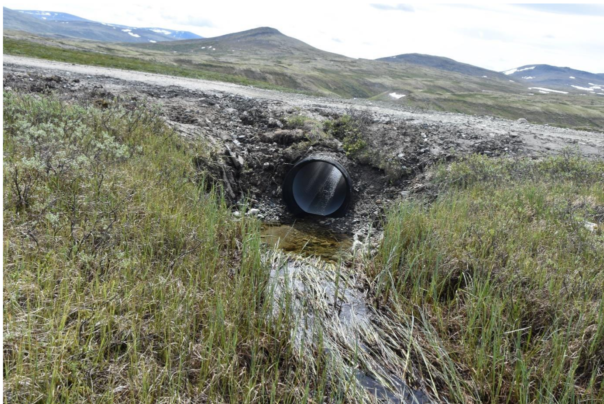
Figur 28: Det ble lagt ned en del nye stikkrenner langs Snøheimvegen.
