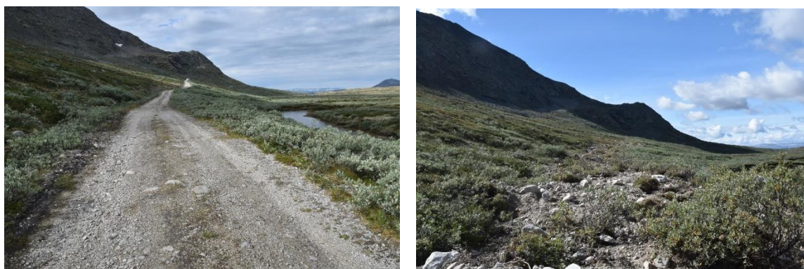
Figur 5: Vegen sørover fra Søndre Grøna bru før og etter tiltak. Denne gikk i halvsjæring oppover vierhei og våtmarkssig. Etter fjerning er opprinnelig terreng og vannveier gjenopprettet.
