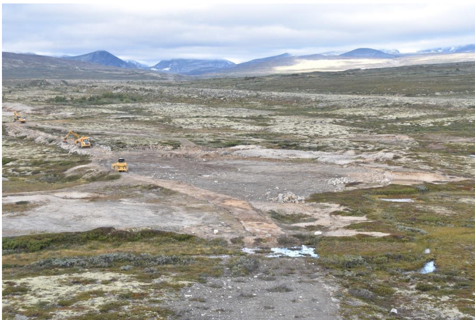
Figur 25: Veien og massetak M5 ble tilbakeført med å ta ned den store veifyllinga og fylle opp det tidligere massetaket.
