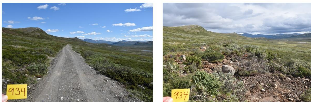
Figur 23: Terrengforming er spesielt krevende i hellende terreng. Her er dette godt løst og naturlig sig og hellinger er formet.
