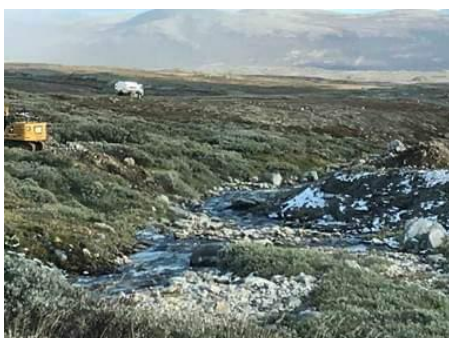
Figur 18: Der veien er bygget ved å skrape sammen masser fra sideterreng består terrengformingen av å bre ut igjen massene. Vegetasjonen i det berørte sideterreng gjenbrukes til slutføring.
