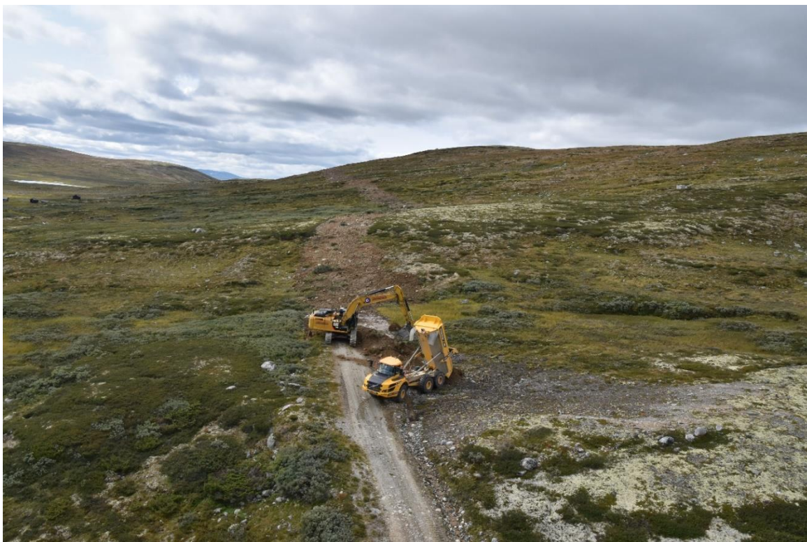
Figur 7: Fjerning av veien ved Grisungvatna ble gjennomført med standardmetoden i prosjektet, der opprinnelig terrengform ble gjenopprettet og på sikt vil vegetasjonen etablere seg i den gamle traseen.
