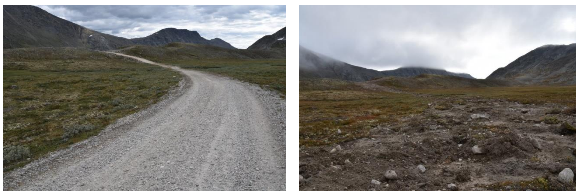
Figur 4: Deler av veien gjennom Grøndalen før og etter tiltak. Strekket gikk gjennom store myrsystemer og kvartærgeologiske løsmasseavsetninger. Over myra er tilkjørte masser fjernet ned til opprinnelig terreng. Over eskeren er terrenget formet slik det trolig var før veien ble bygd.
