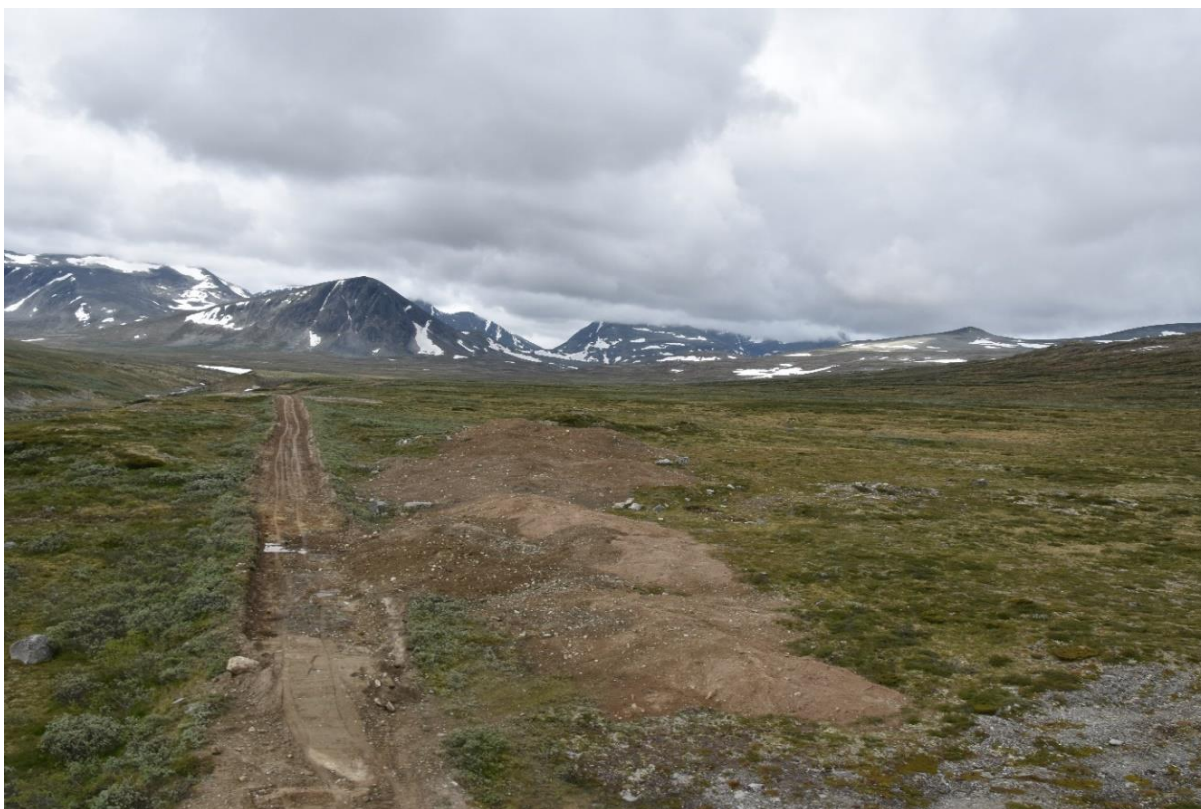
Figur 17: Overskuddsmasse fra veiene ble lagt tilbake i gamle massetak. Noen av disse massetakene var opprinnelig kvartærgeologiske formasjoner som nå ble tilbakført slik at de inngår i det helhetlige landskapet, samtidig som de ikke skal framstå som kopier eller kulisser av et tidligere urørt landskap. Bilet er tatt undervegs i anleggsarbeidet der overskuddsmasse er skavet av, men revegetering og slutføring gjenstår.
