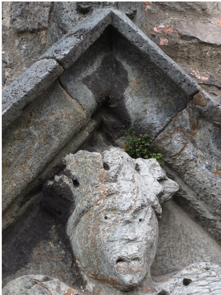
Detalj av våpentavle med skulptur av kleberstein midt på hovedfasaden. Forvitret stein, sorte skorper og begroing med murburkne.
