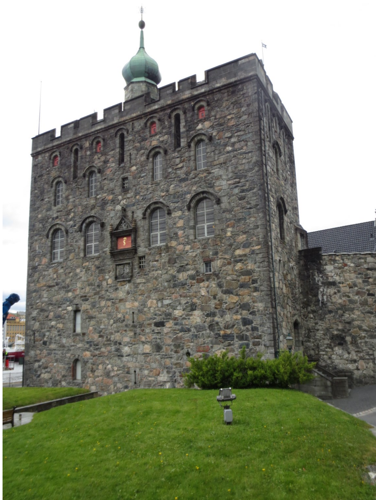
Renessansefasaden mot byen. Bak kreneleringen rundt vektergangen skjuler det seg et skifertekket saltak av støpt betong.
