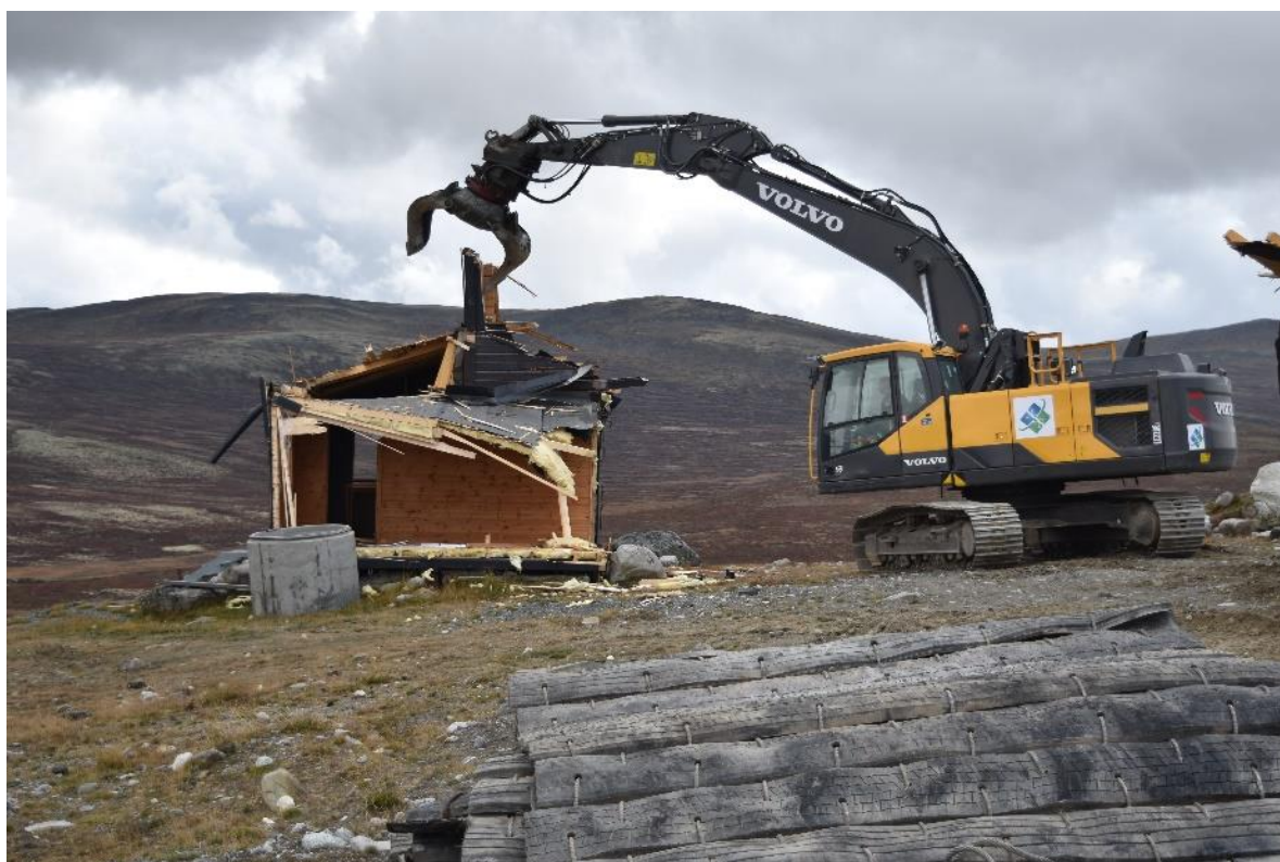
Figur 13 OP-hytta ovenfor Rollstadsetrene plukkes ned. Skytemattene i forgrunnen ble lagt oppå terrenget der det var behov for å unngå nye kjøreskader. Foto: NINA
