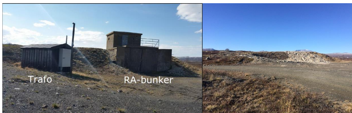
Figur 10 Bunker og trafo ved Veslefallet ble revet i september 2016. Foto: Forsvarsbygg.
