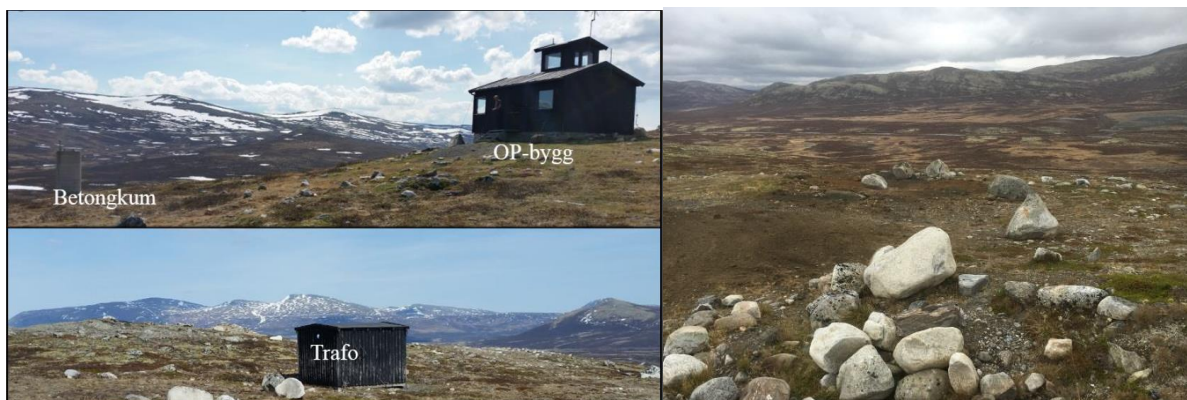
Figur 12 Fly-OP og trafoen ovenfor Rollstadsetrene ble fjernet i september 2016. Foto: Forsvarsbygg
