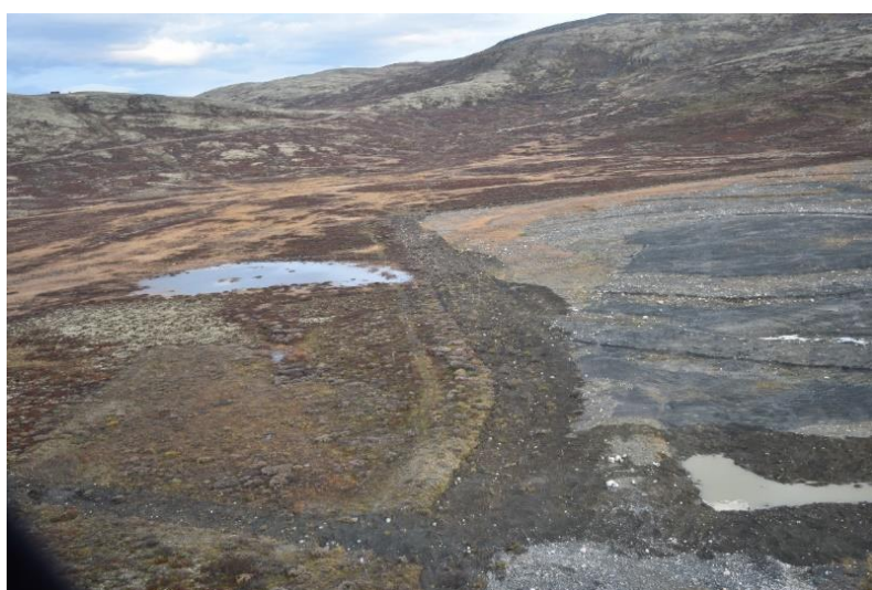
Figur 7 Da grøfta rundt HFK-sletta ble lagt igjen, ble vatnet leda ut i Stormyra og det ble på kort tid etablert et lite tjern med vannspeil. Bildet et tatt fra samme retning som fig 6, men fra luften. Foto: NINA
