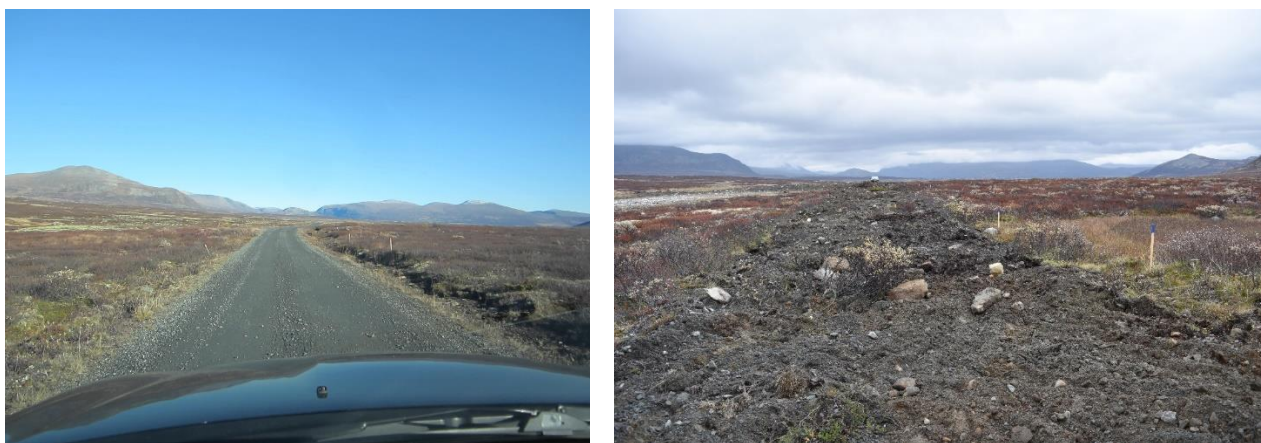
Figur 14 Siste strekningen av vegen inn til HFK ble fjerna i september 2016. Førstusituasjonen til venstre. Foto: Harald Snippen/Dagmar Hagen
