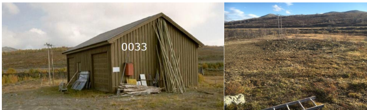
Figur 11 Lager Grisungen. Etter riving av bygg ble terrenget rufset forsiktig til slik at lokale masser ble liggende i dagen som grunnlag for gjenvekst. Foto: Forsvarsbygg
